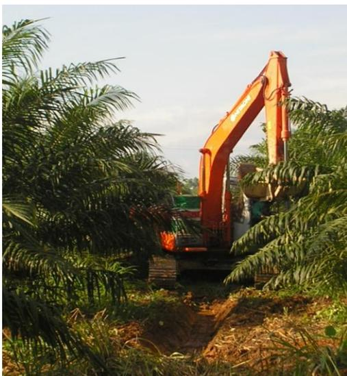
Con el diseño ya elaborado se va a campo y mediante la utilización de sistemas de georeferenciación se realiza el trazado de los canales a partir de la instalación de estaquillas.
