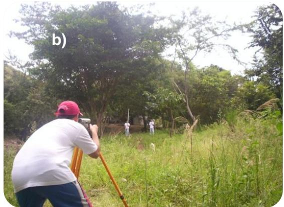
**Fotos 6. a) Sitio de proyección para Bocatoma en canal El Túnel y b) Nivelación para el diseño del desarenador**
