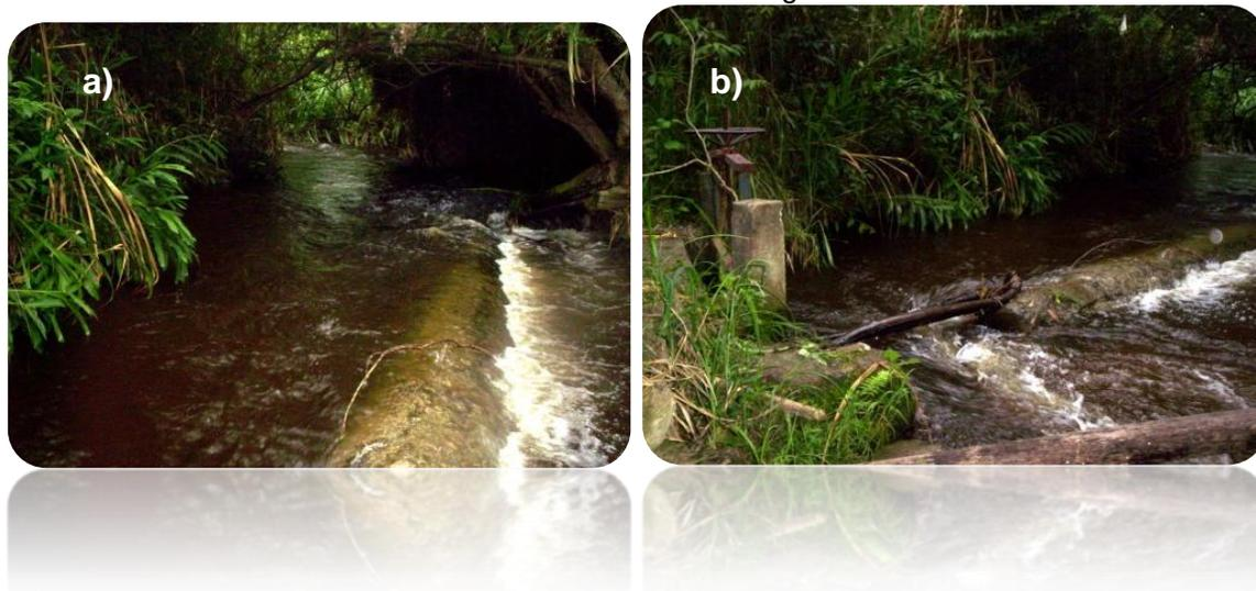
**Fotos 7. a) Sitio para Bocatoma en el canal Chichato y b) Compuerta existente para conducir al lavado del desarenador**
