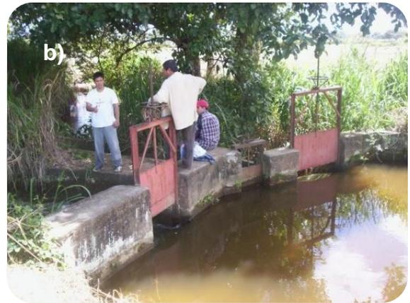
**Fotos 1. a) Vista general de ubicación de un Partidor de caudal en el canal El Túnel (La Ye) y b) compuertas de salida en el partidor de caudal**
