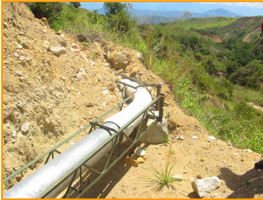
Gráfico 1. Ensillada de la tubería principal, viaducto en 8”.
