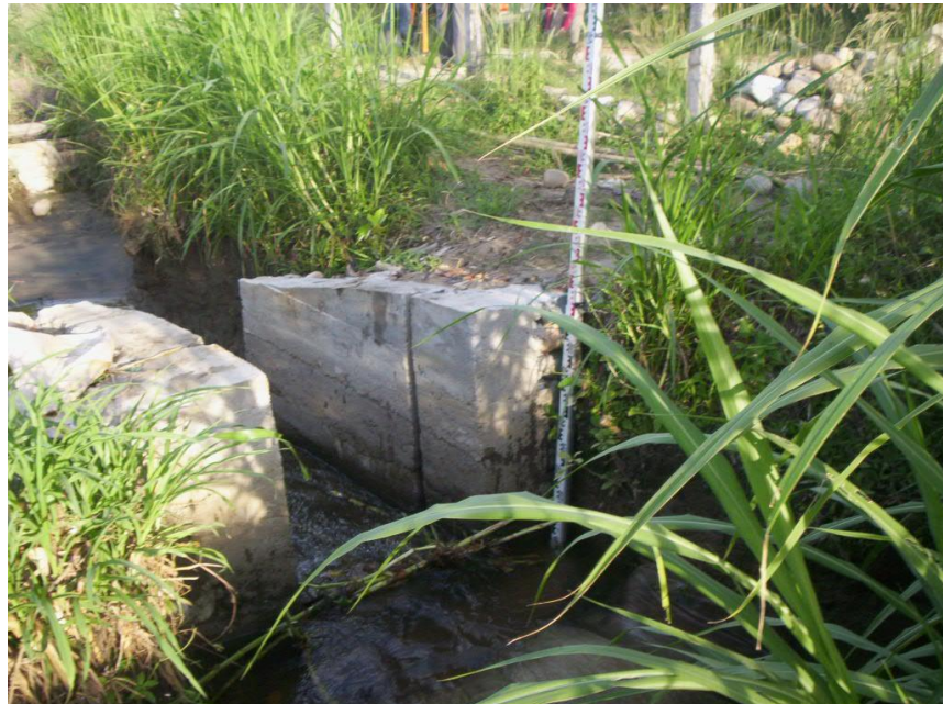
Foto 8. ) Vista General del sitio proyectado para Toma Predial sobre el Canal La Murcia (predio de Maria Margarita Escobar)
