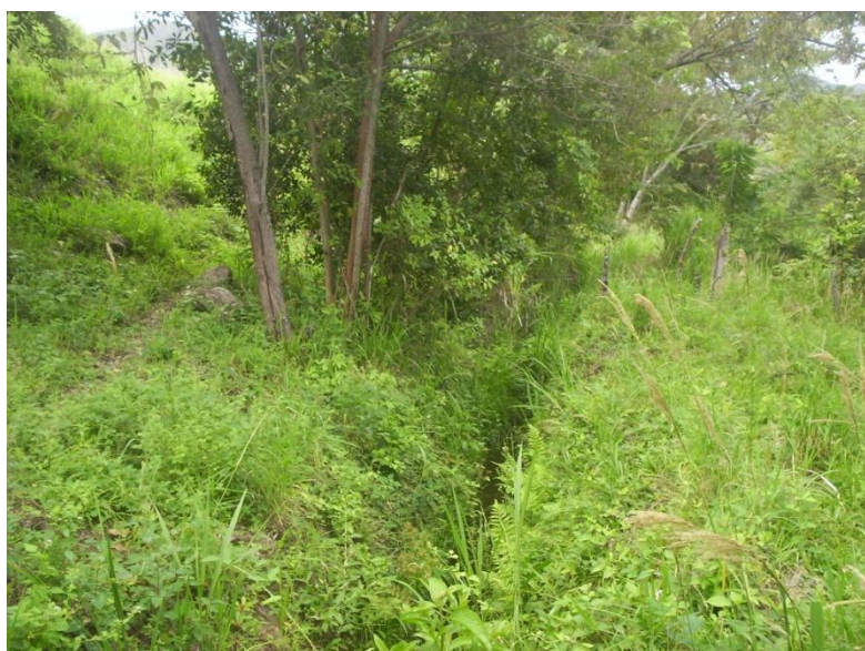
Foto 4. ) Vista General del sitio proyectado para el Desarenador sobre Canal San Andrés
