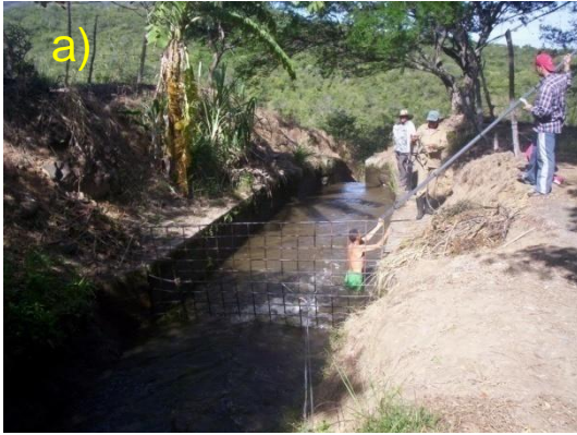
Fotos 1. a) Vista General de un Desarenador En El Canal El Tunel y b) Compuerta de lavado.
