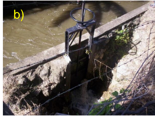
Fotos 1. a) Vista General de un Desarenador En El Canal El Tunel y b) Compuerta de lavado.
