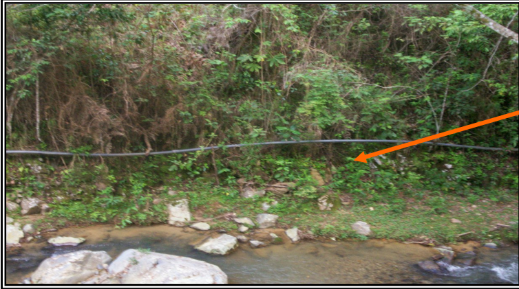
Figura No. 9. Tubería descubierta sin ninguna protección
