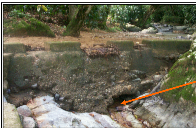
Figura No. 5. Socavación y encajonamiento al dique toma
