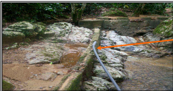
Figura No. 6. Falencia en el encofrado de la tubería y rotura
