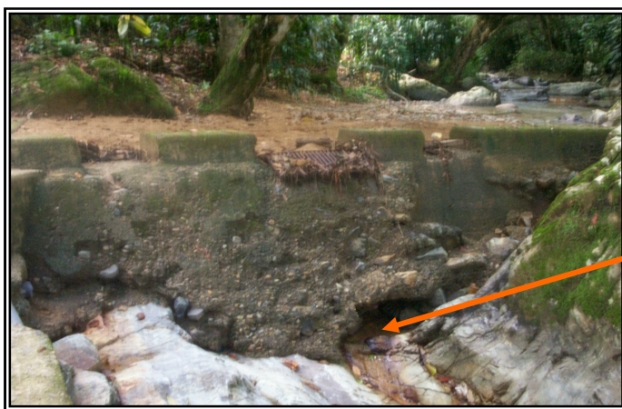
Figura No. 5. Socavación y encajonamiento al dique toma
