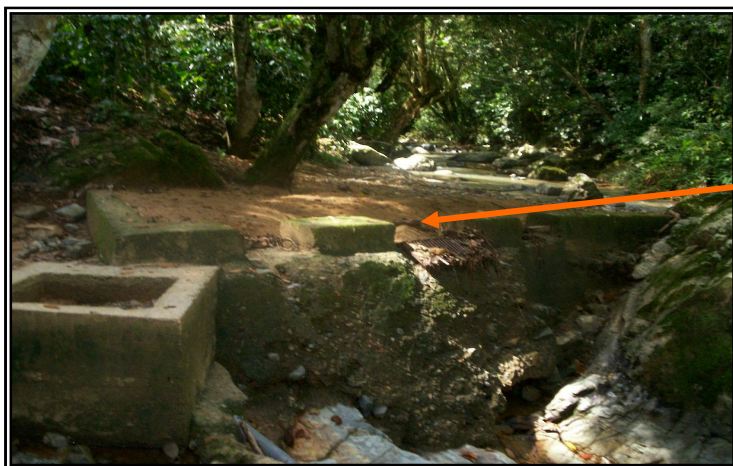
Figura No. 4. Colmatación en el dique toma
