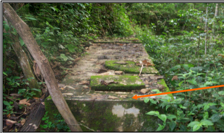
Figura No. 7. Mal estado del desarenador
