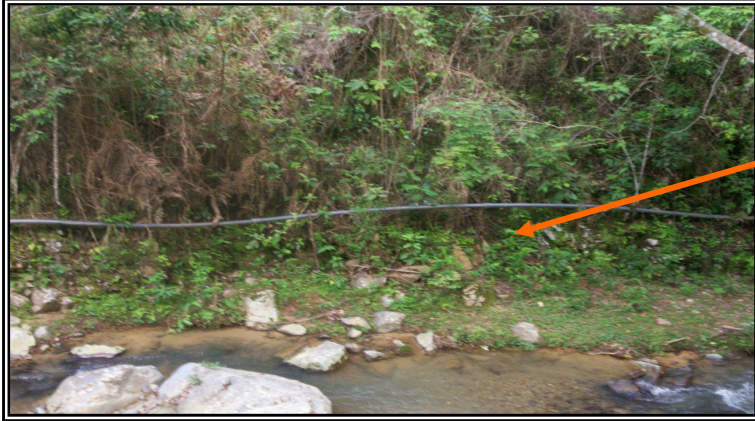
Figura No. 9. Tubería descubierta sin ninguna protección
