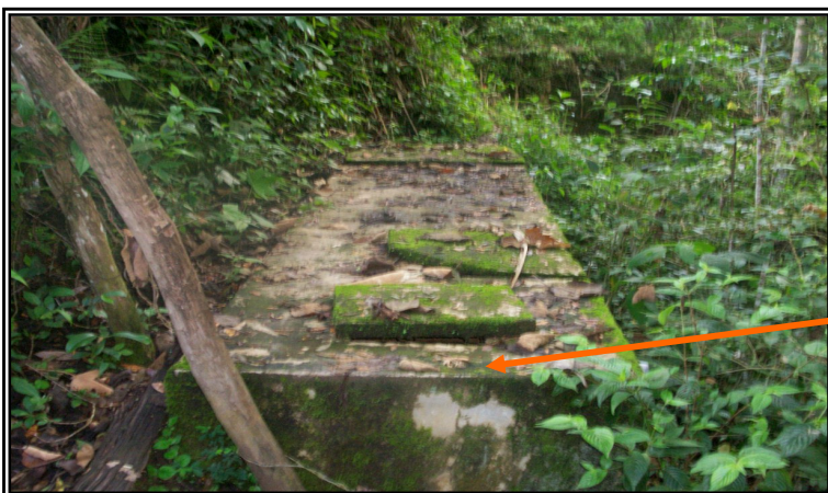
Figura No. 7. Mal estado del desarenador
