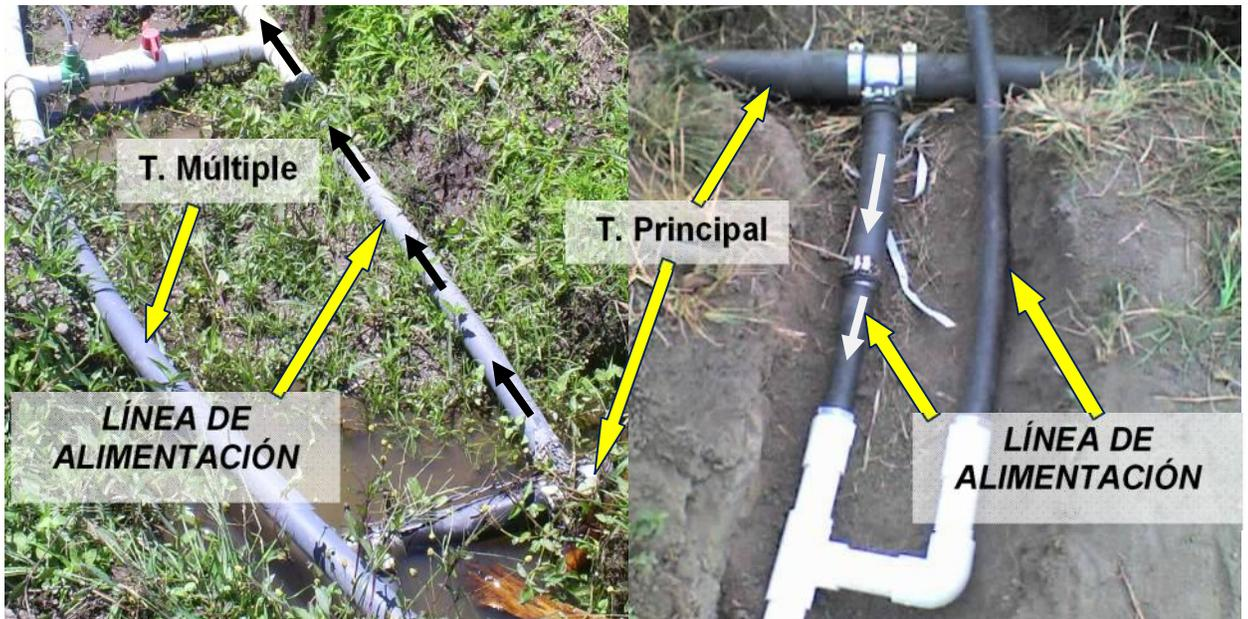
**Fig. N.26. Distribución de la línea de alimentación instalada en el lote Guayabal**
