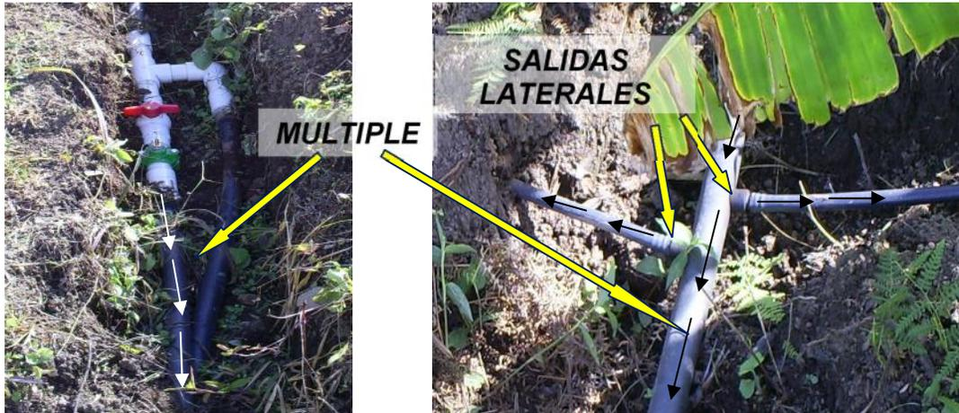
Fig. VIII. Conexión de Montaje de reparto y salida de la distribución de la manguera Lateral.
