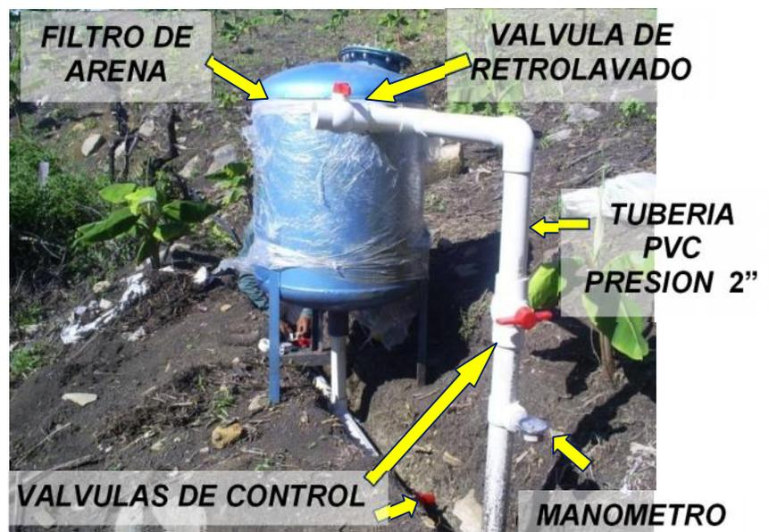
**Fig. VI. Descripción del filtro de arena instalado en el lote Los Medios.**
