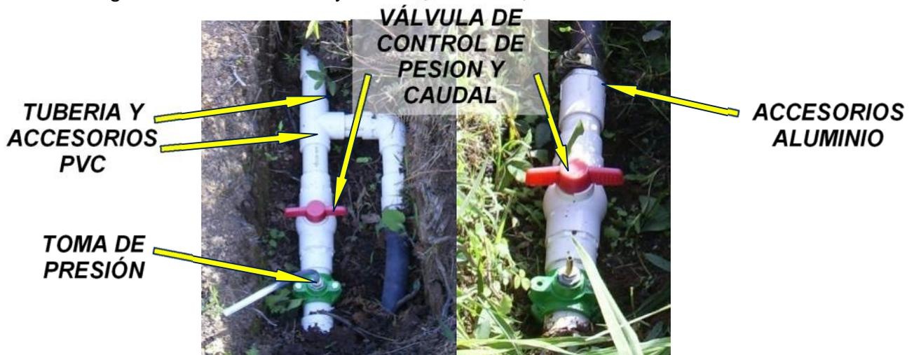
Fig. IX. Conexión de Montajes de reparto.
