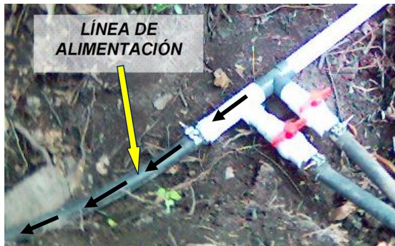
Fig. IV. Distribución de la línea de alimentación instalada en el lote El Recuerdo.
