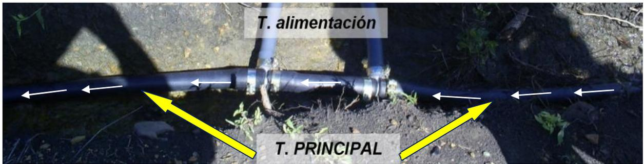
**Fig. VII. Distribución de la línea principal instalada en el lote Los Dindes.**
