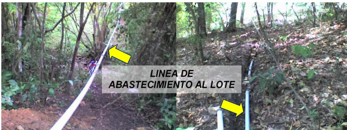
**Fig. IV. Línea de abastecimiento al lote, instalado en tubería PVC de 2".**
