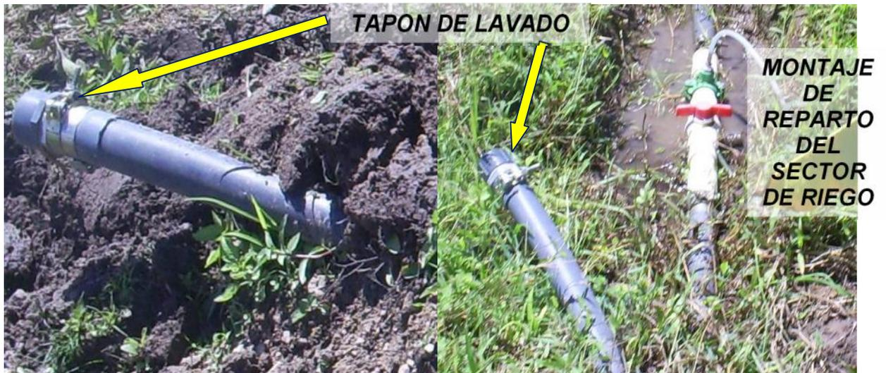
**Fig. N.30. Tapones de lavado instalados en el lote Guayabal (la foto de la derecha tapón de lavado al final de la tubería de distribución múltiple y la de la izquierda tapón de Lavado tubería principal.**
