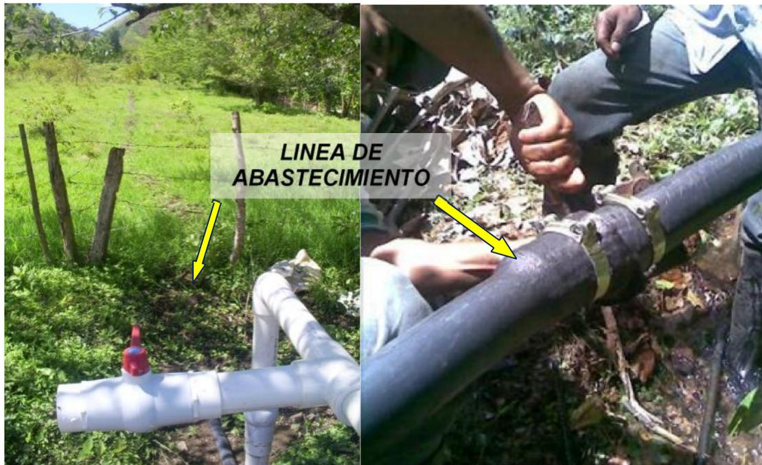
**Fig. III. Línea de abastecimiento al lote Barbillas, instalada en manguera de polietileno de 3".**
