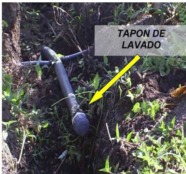
Fig. X. Tapón de lavado instalado en el lote Santa Helena.
