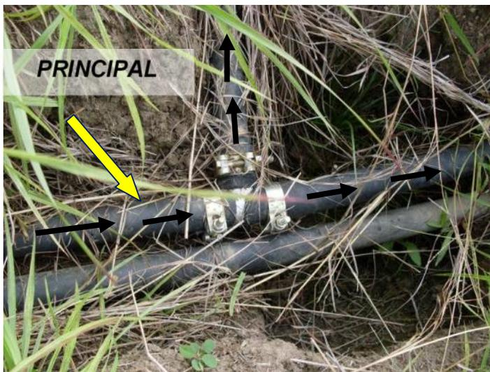
La distribución principal consta de la instalación de manguera de polietileno de 1 1/2", con accesorios en aluminio y abrazaderas de 1 1/2" tipo industrial, que cumple la función de recibir y conducir el agua que sale de la unidad de filtrado hacia las distribuciones de alimentación.
