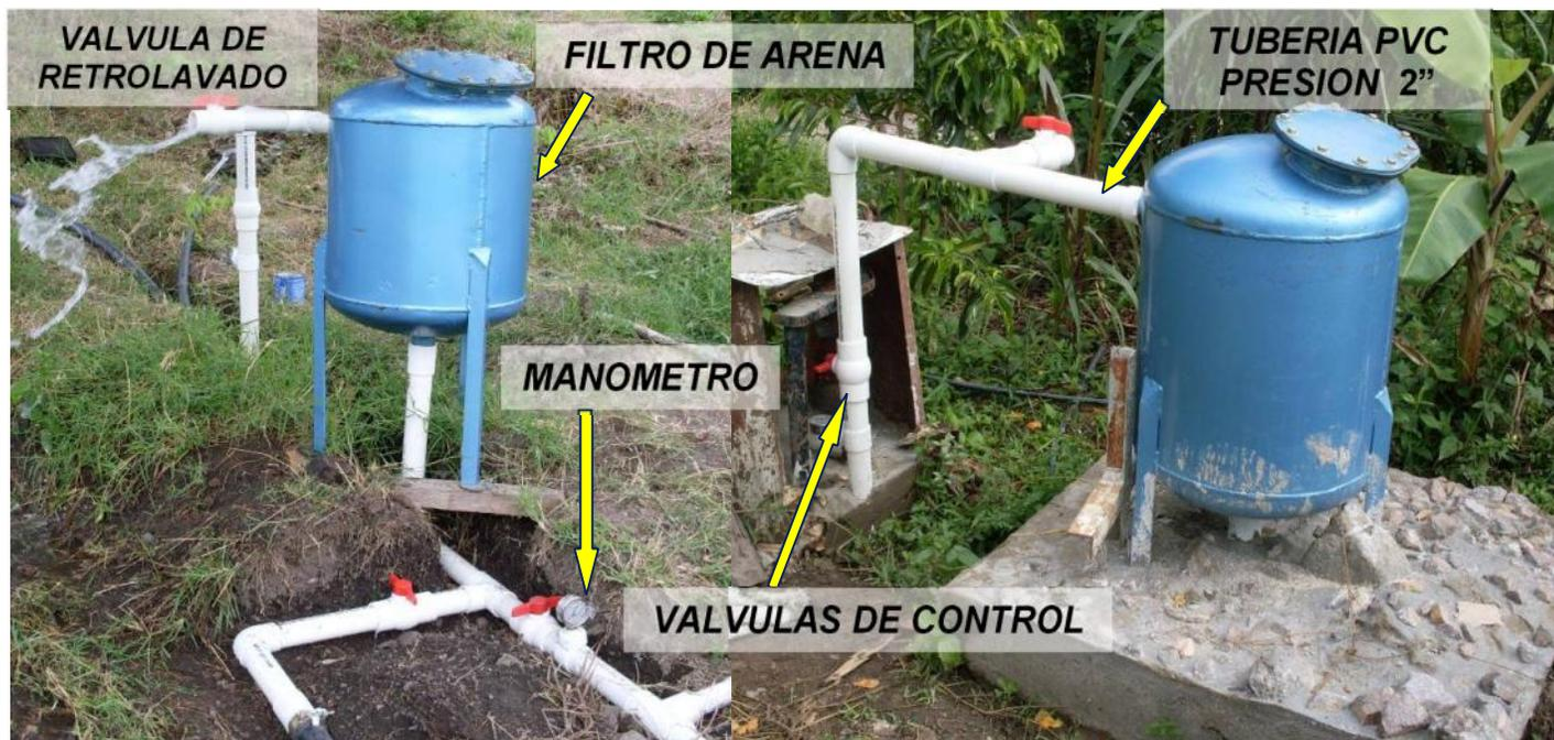
**Fig. III. Descripción de los filtros de arena instalados en el lote La Victoria, el de la izquierda corresponde al instalado en la parte alta del lote y el de la derecha instalado en la parte baja.**
