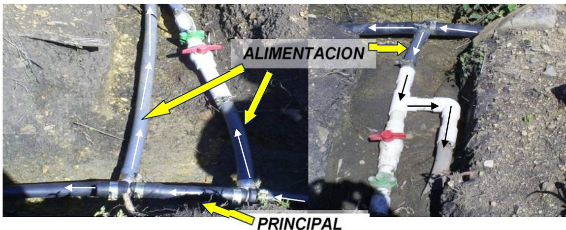
**Fig. VIII. Distribución de la línea de alimentación instalada en el lote Los Dindes.**
