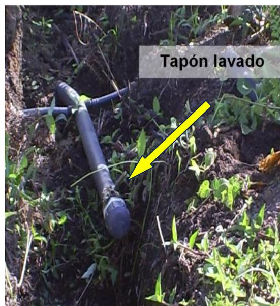
Fig. X. Tapones de lavado instalado en el lote Los Medios
