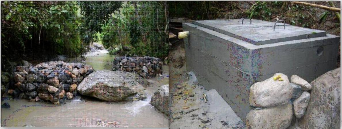
**Fig. II. Toma de agua y desarenador construidos para el predio Barbillas.**
