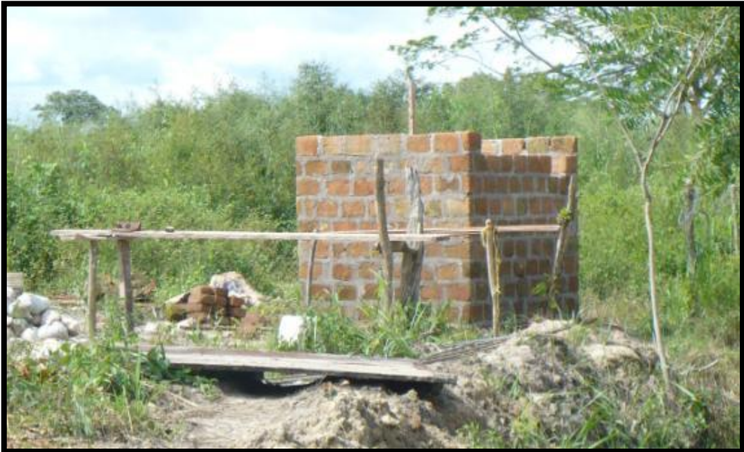
Fotografía 6 Construcción de casetas
