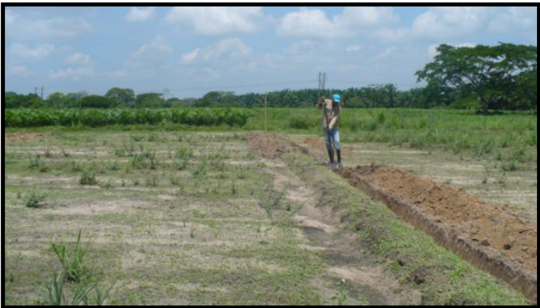
Fotografía 4 Alineación y abertura de zanjas para instalación de la tubería
