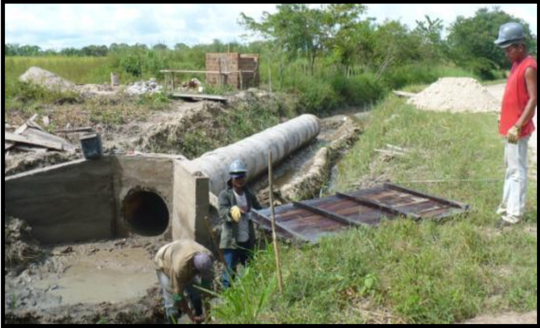
Fotografía 5 Adecuación del canal de riego “El limón”
