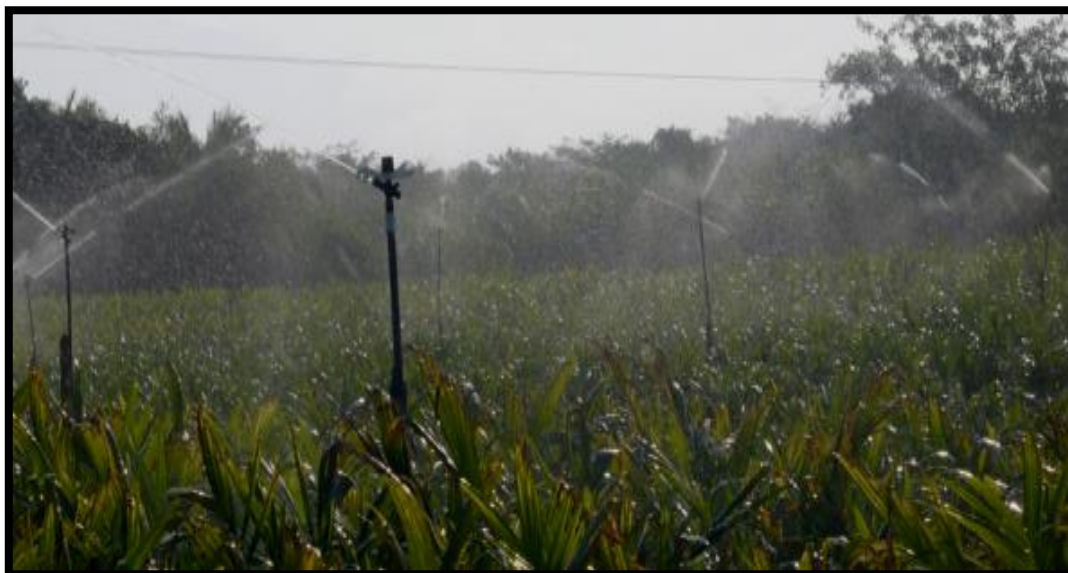
Fotografía 12 Prueba del sistema de riego
