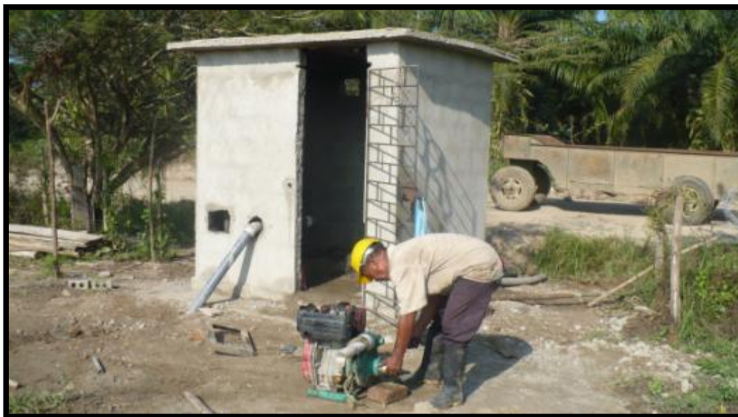
Fotografía 10 Montaje de bomba
