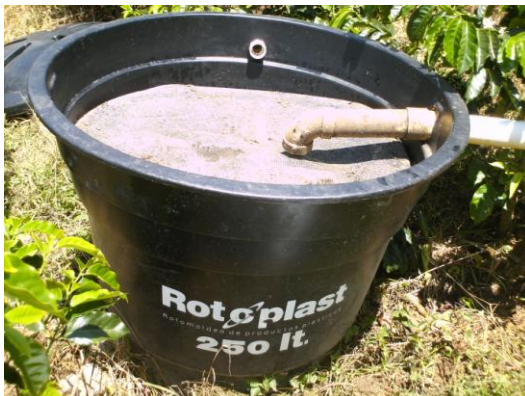
Figura 24. Reactor Hidrolítico – Acidogénico RHA (SMTA 180) Finca: Villa Linda
