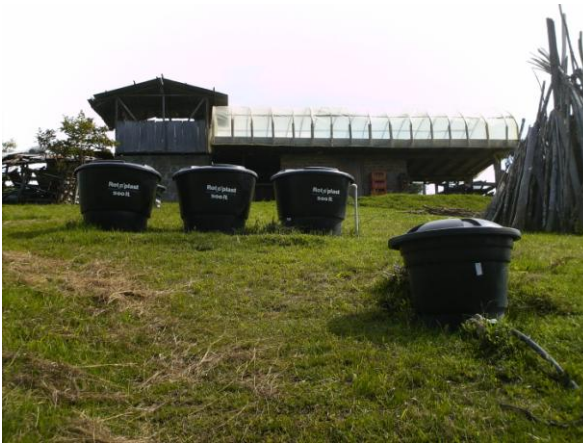
Figura 22. Sistema de tratamiento Modular Anaerobio (STMA 360) Finca: Bella vista
