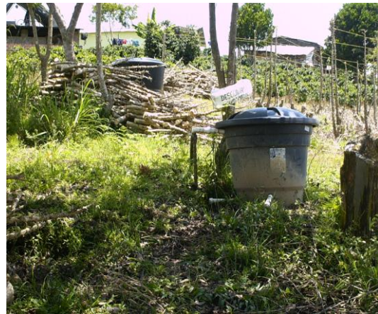
Figura 23. Sistema de tratamiento Modular Anaerobio (SMTA 180) Finca: Villa Linda
