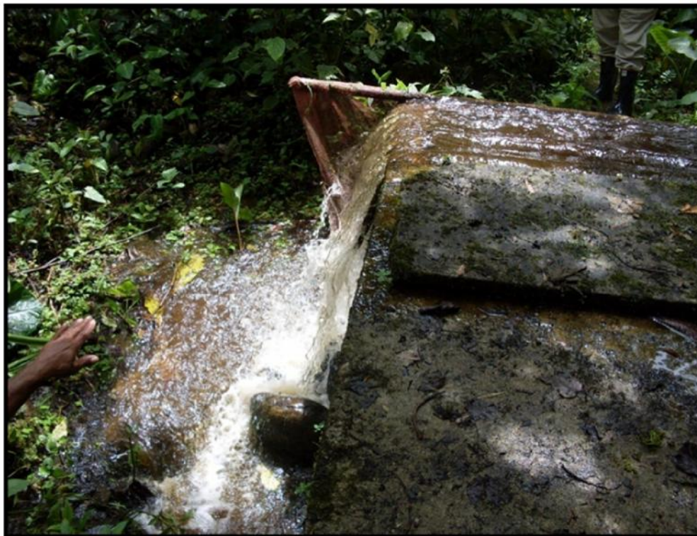
Foto 3. Desarenador Construido Rebosado
