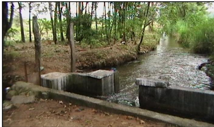
*Foto 5. Medidor de caudal fuente de abastecimiento del proyecto, Canal El Túnel.*
