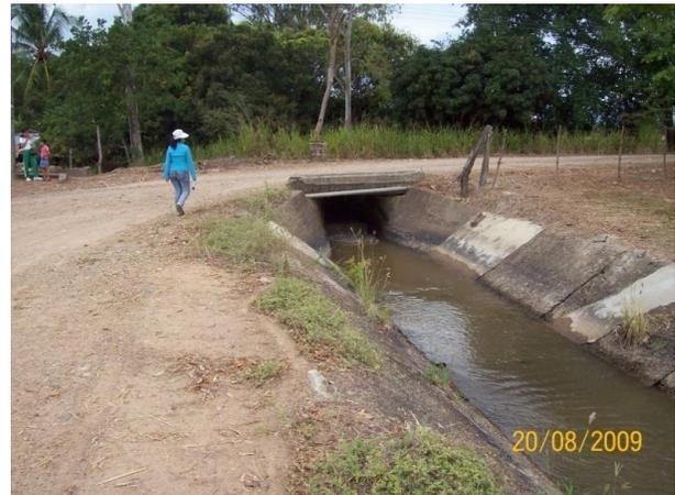
**Derivación del canal lateral 4 OPIA al canal 4C.**
