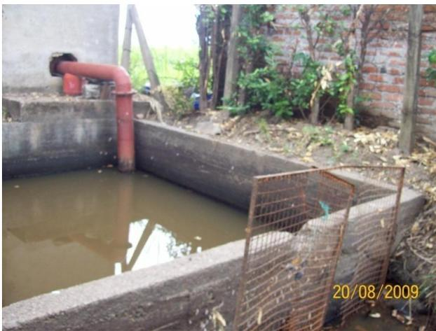
**Cárcamo, tubería de succión para el bombeo.**
