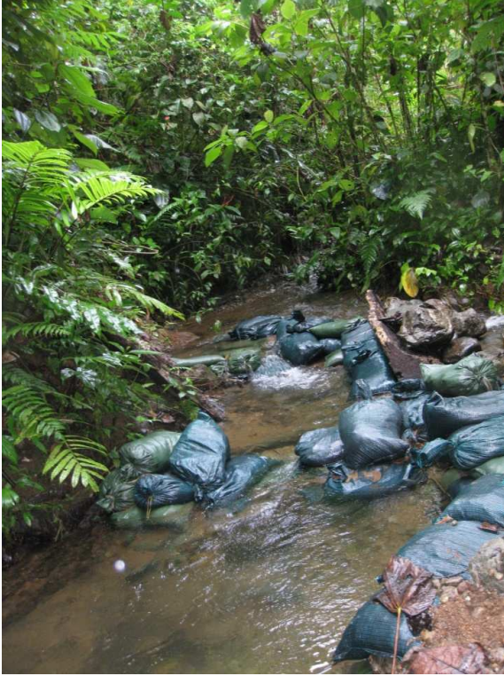
Figura No. 3. Sacos terreros después de una creciento
