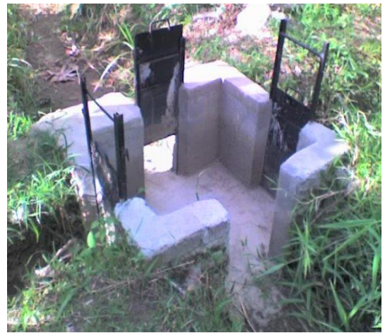
Figura 13. Construcción de cajilla de distribución
