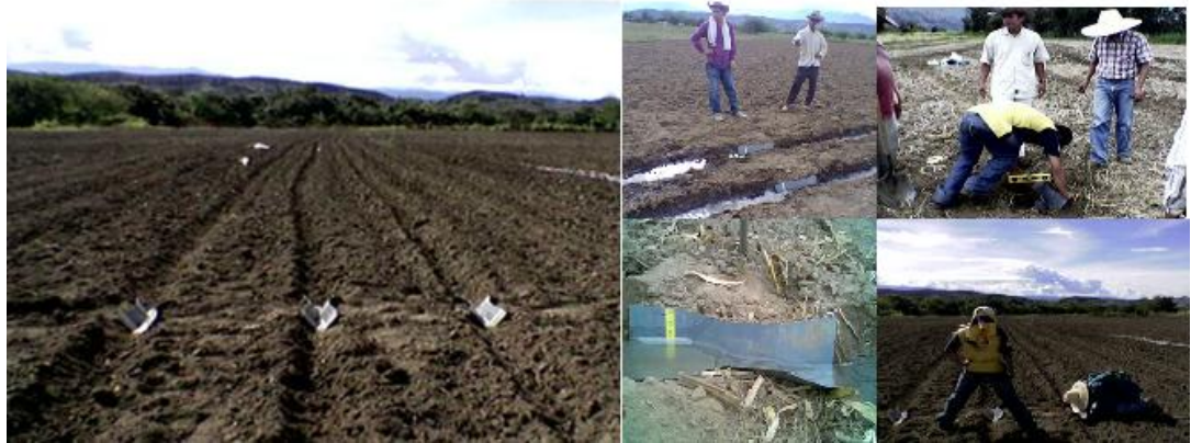
Figura 2. Instalación, nivelación y calibración de las Canaletas aforadoras WSC
