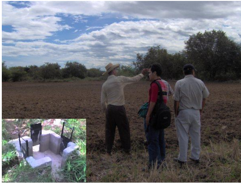
Figura 7. Proyección del trazado del sistema en campo y detalle de la cajilla de distribución de caudal
