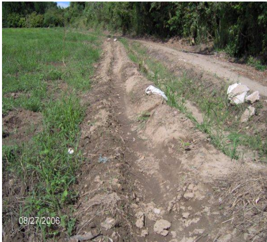
Figura 11. Construcción de las acequias principales de riego.
