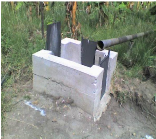
Figura 13. Construcción de cajilla de distribución
