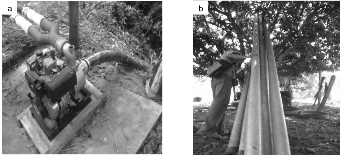
Figura 14. a) Instalación de la unidad de Bombeo y b) tubería de conducción de riego
