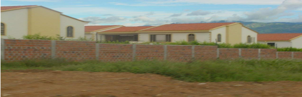
FOTO 4. Conjunto Residencial Caminos de Oriente. Km 1 via Vegalarga. Abril 27 de 2003.
