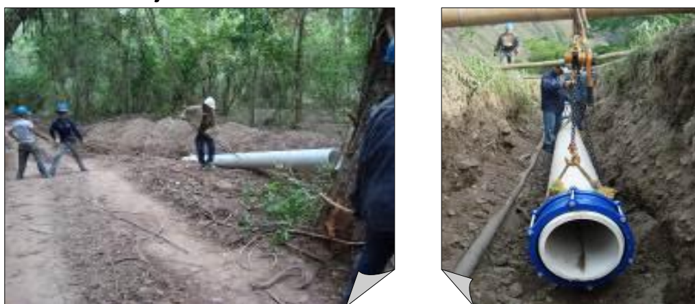
Fotos 7. Bajada de la Tubería a la excavación e izada de la misma.
