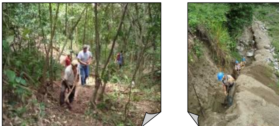
Fotos 5. Excavaciones Manuales para tubería 14" zona conducción Principal
