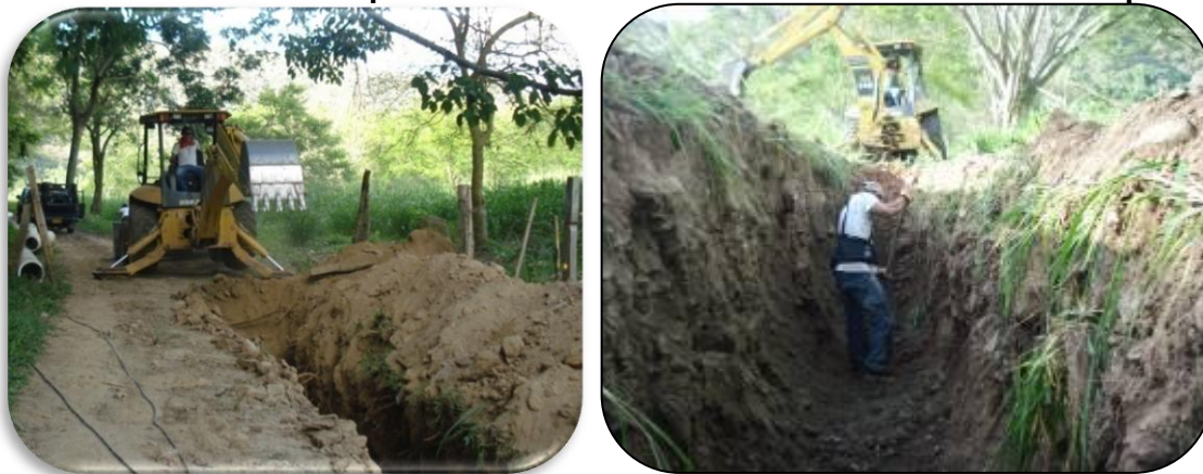
Fotos 4. Excavaciones para tubería 14" RDE 13.5 zona conducción Principal
