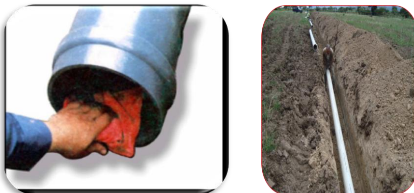
Figura N° 8: Limpieza y Alineación de la Tubería a Instalar.
