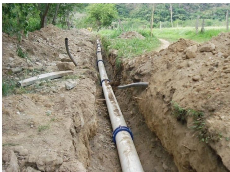
Foto 10. Tubería 14" RDE 13.5 Instalada
