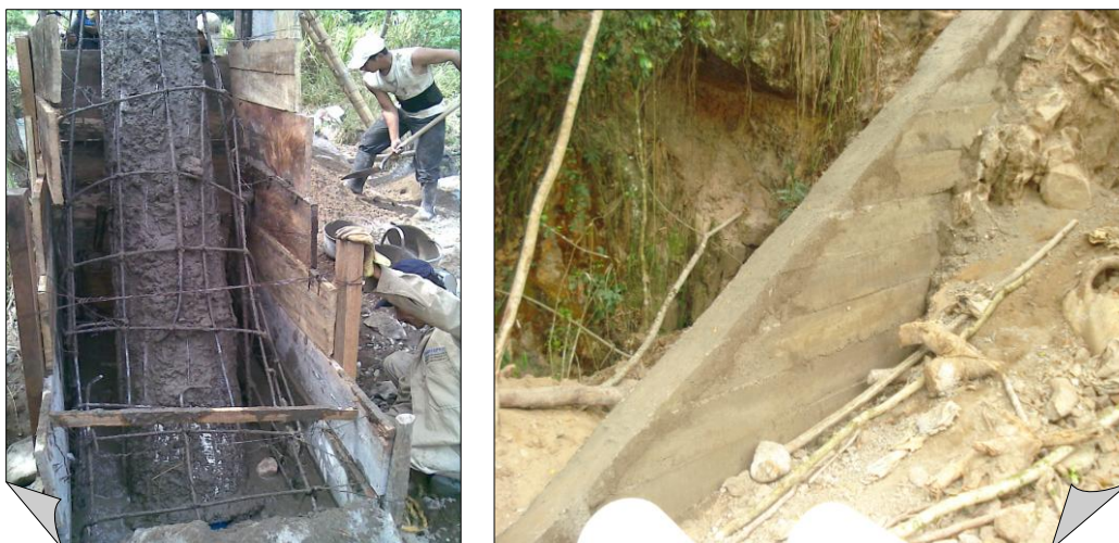
Fuente: Ingeniería de Riegos y Obras Civiles Ltda. 2010
