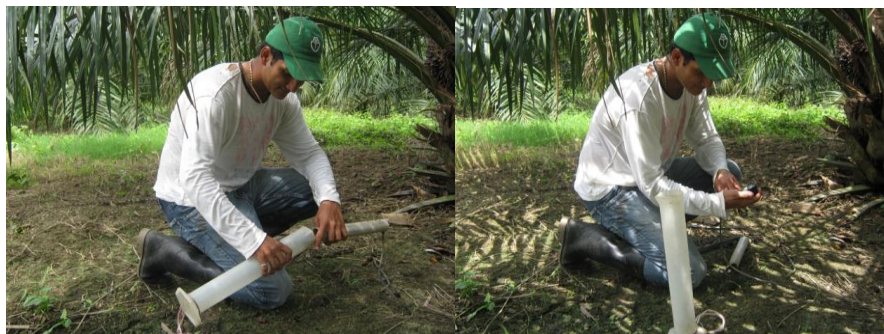
Foto 11. Aforo y medición de presión en el sistema de riego
