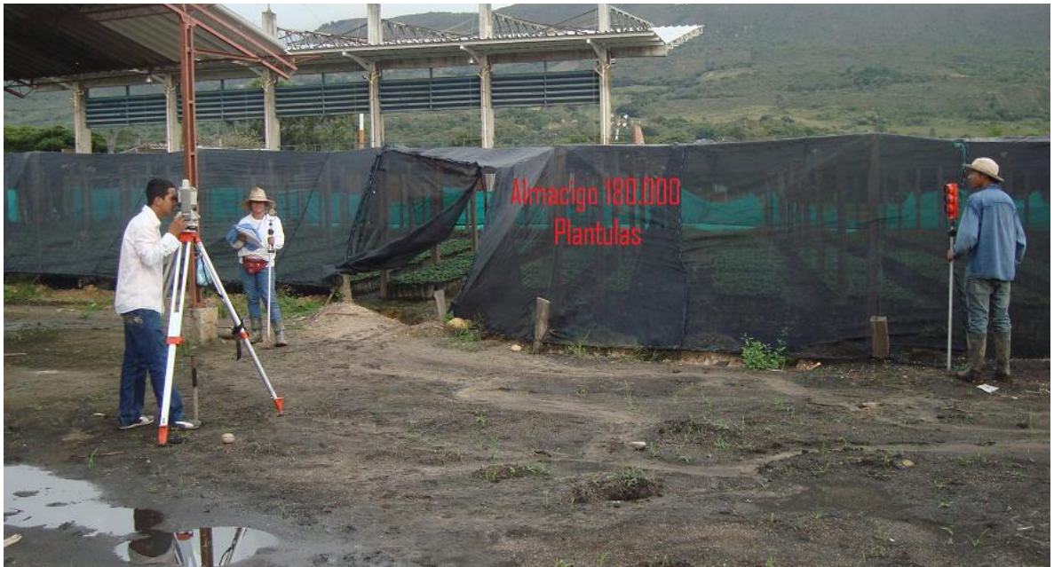
Figura 3. Levantamiento Topográfico Estación Total (Topcon)
