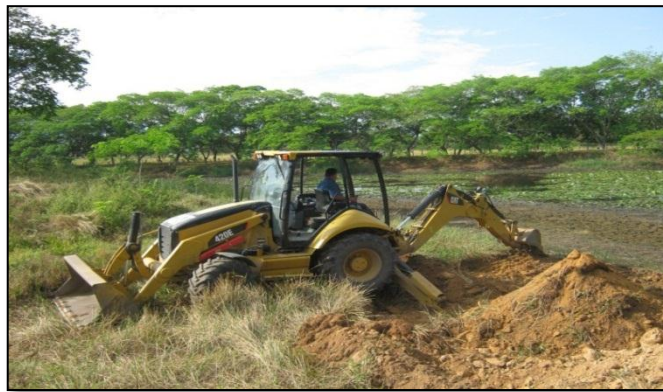
Figura 11. Inicio de la excavación y extracción de sedimentos.
