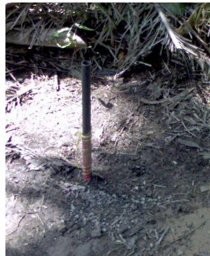
Foto 11. Instalación de freaímetros
