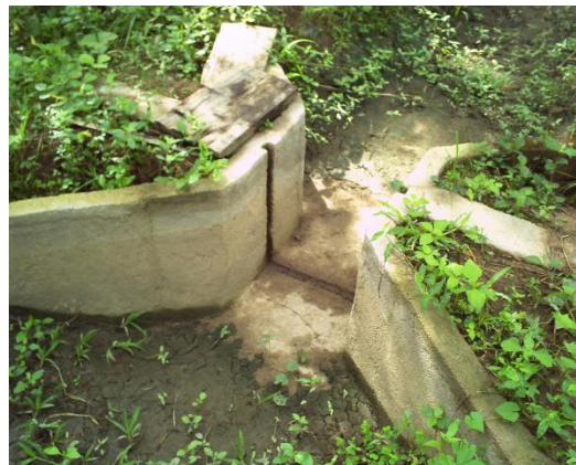
Foto 5. Vertedero canal de riego
