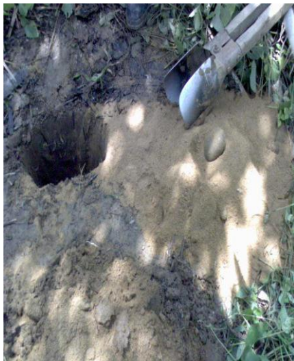
Foto 10. Instalación de freaímetros
