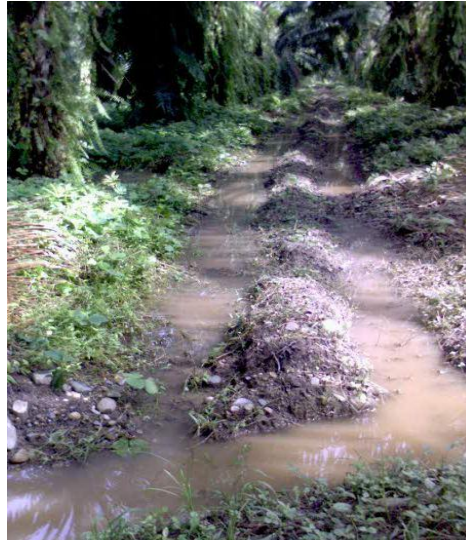
Foto 6. Revisión del sistema de riego
