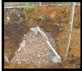
Foto 3. Construcción de base para estación
