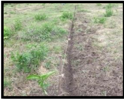
Foto 18. Excavación de múltiples y laterales.
