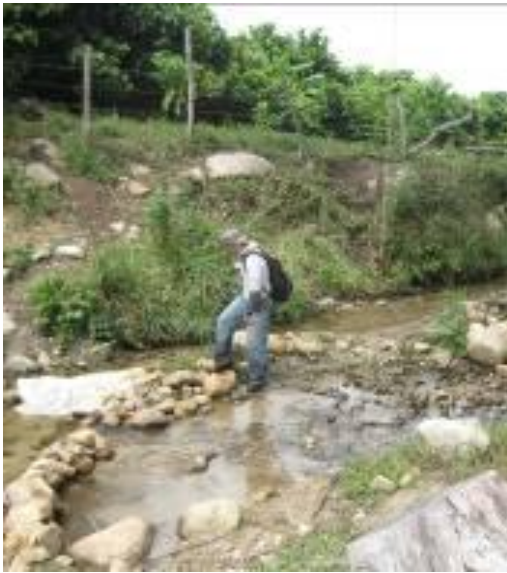
Figura 5 y 6. Estructuras artesanales de captación y conducción encontradas en el cauce de la quebrada la Sardinata
