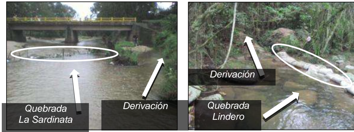
Foto 1 y 2. Derivaciones tipo fusible con ocupación total del cauce.
