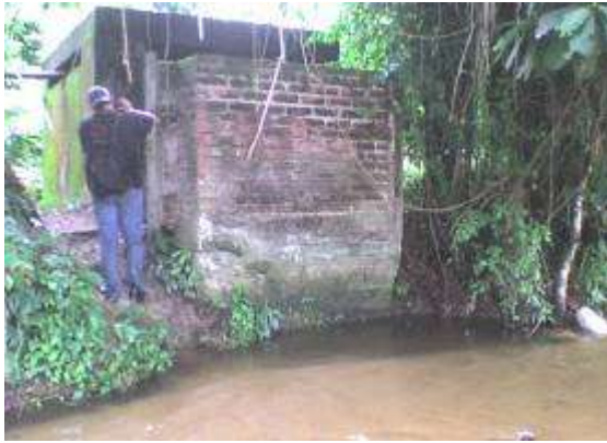
Foto 18. (18D9D). Caseta Bombeo.
