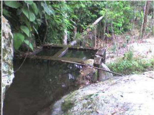
Foto 7. Represa y tubería de conducción.
