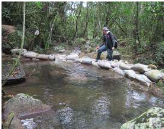
Foto 21. Derivación por costales y rocas
