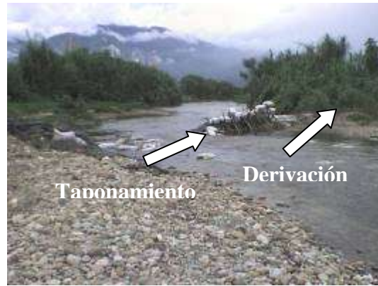
Foto 9. Obstaculización Sobre La Quebrada Sardinata.
