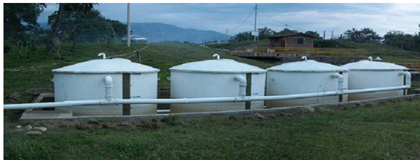
Figura 14: Filtros anaerobios (FAFA)
