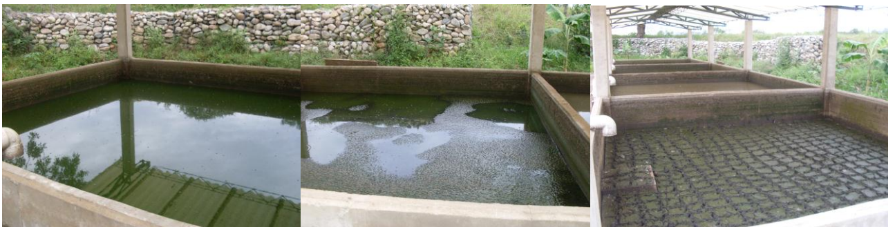
Figura 17: Etapas de Secamiento en los lechos de Secado
