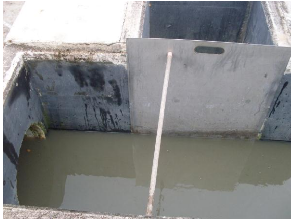
Figura 8: Canal de Entrada y Vertedero de excesos
