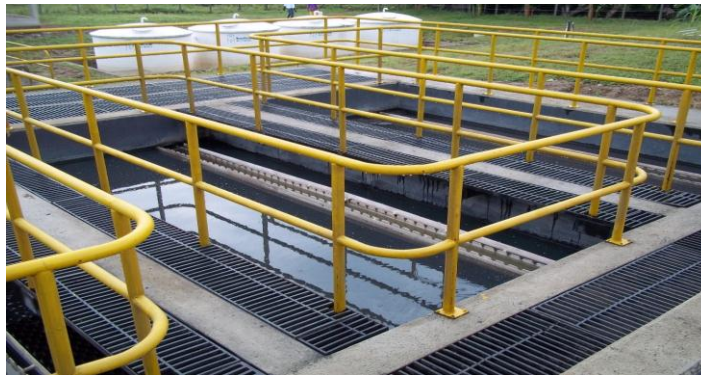
Figura 13: Sedimentadores de alta tasa
