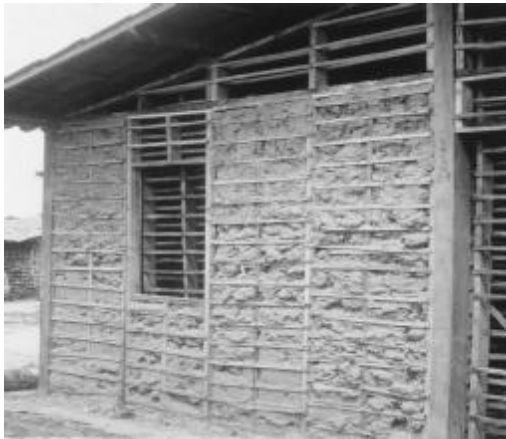
Fotografía No. 12. Vivienda construida con elementos prefabricados por el centro de Pesquisas y Desenvolvimento (CEPED), Camari, Brasil.
