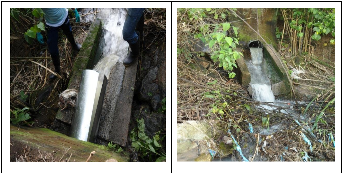
Foto No.15 vertimiento No.2.
