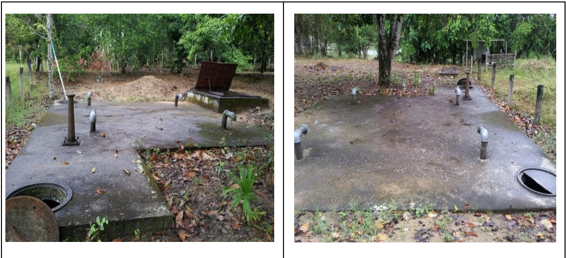
Foto No.11 Tanque 1.
