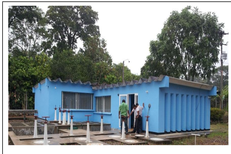
Foto No.9 Caseta de planta.
