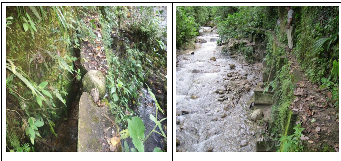
Foto No. 2 Aducción.
