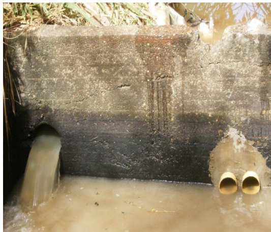
Fotografía 8. Llegada de la Tubería de aducción al carcamo
