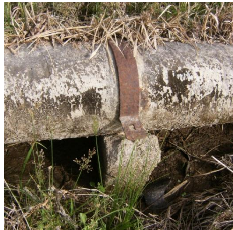
Fotografía 4. Semicorreas de amarre de la tubería a los soportes.
