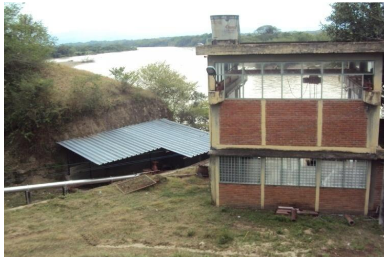
Figura 8. Casa principal de bombeo distrito de riego Asoporvenir
