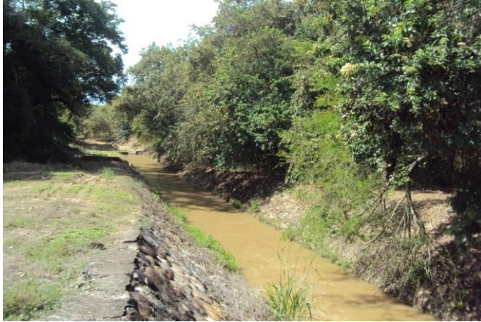
Figura 6. Canal Polonia distrito de riego Asoporvenir
