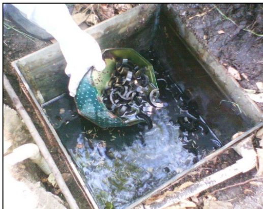
Extracción del medio filtrante de forma manual
