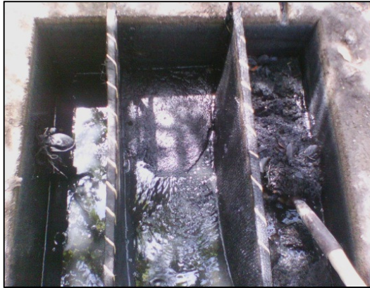
Remoción de sólidos en la cajilla Sedimentadora
