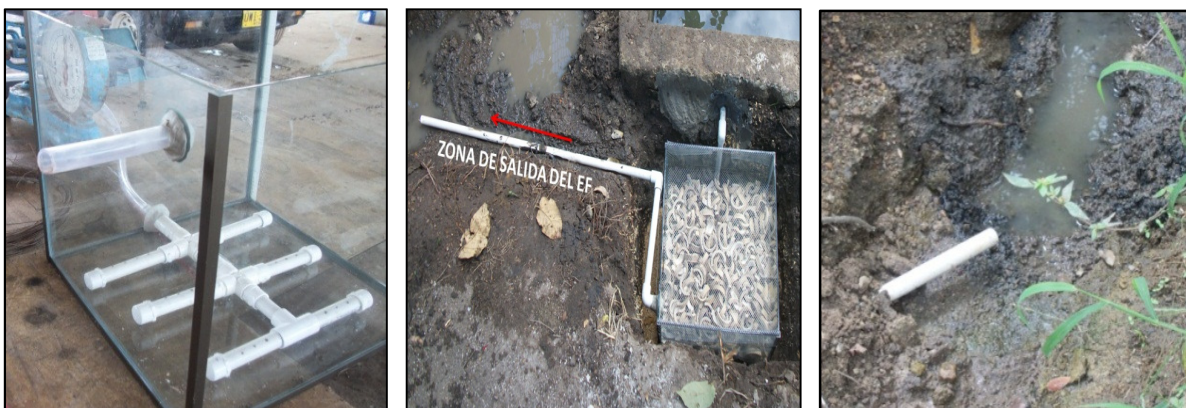
Figura 17. Zona de salida del filtro
