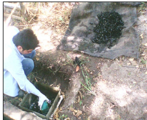
Extracción del medio filtrante de forma manual
