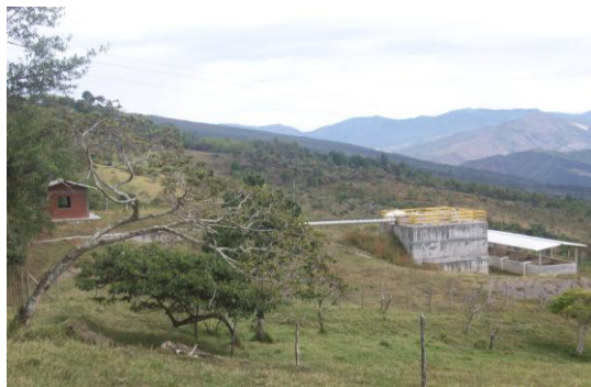
Figura 5. Planta de tratamiento de aguas residuales Nátaga – PTAR.
