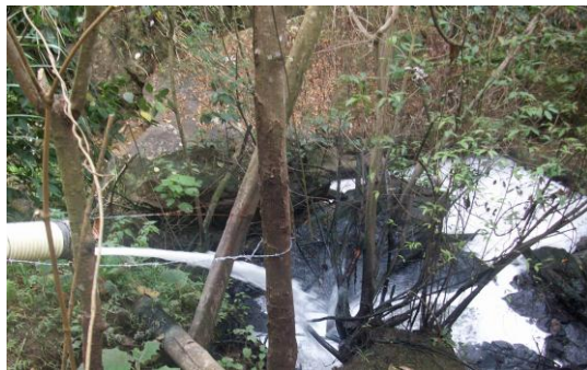
Figura 7. Vertimiento del efluente de la PTAR a la quebrada El Pueblo.
