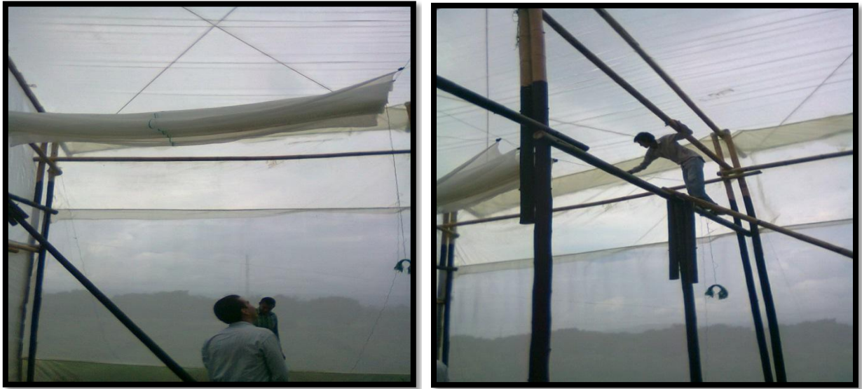
Ilustración 30. Instalación Polisombra
