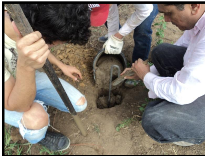
Ilustración 22. Fundición de los muertos
