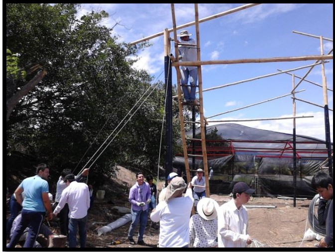
Ilustración 23. Instalación de los templetes.
