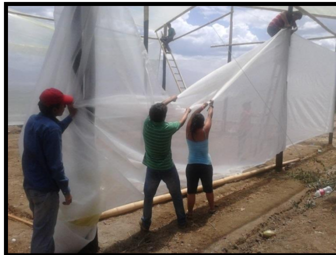
Ilustración 26. Instalación Malla Anti-trip
