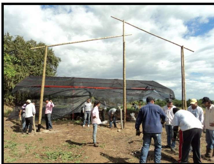
Ilustración 20. Montaje de la estructura en el sitio de estudio.
