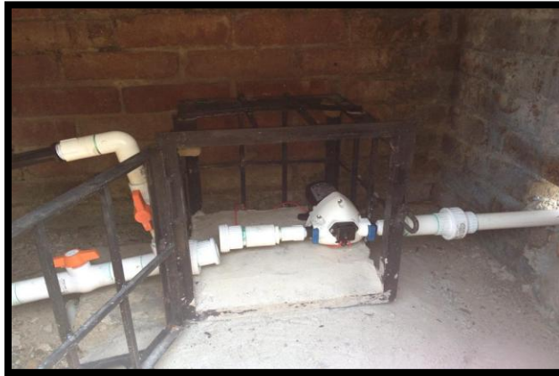
Ilustración 32. Instalación sistema de riego
