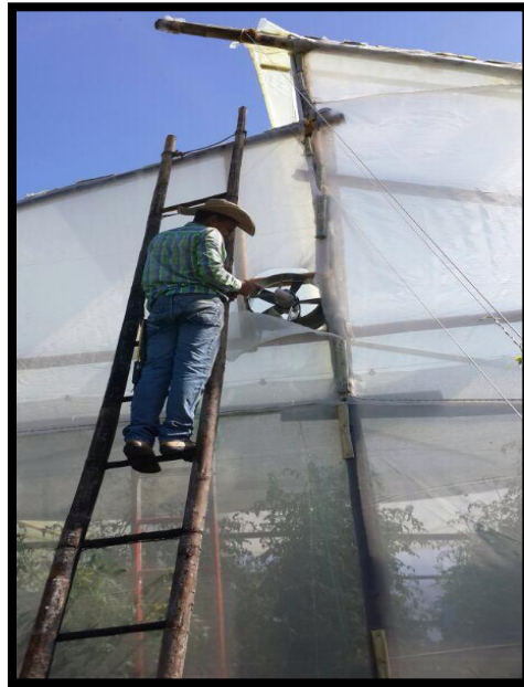
Ilustración 34. Instalación de la ventilación
