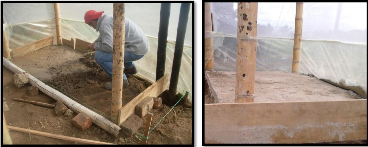
Ilustración 27. Placa de concreto
