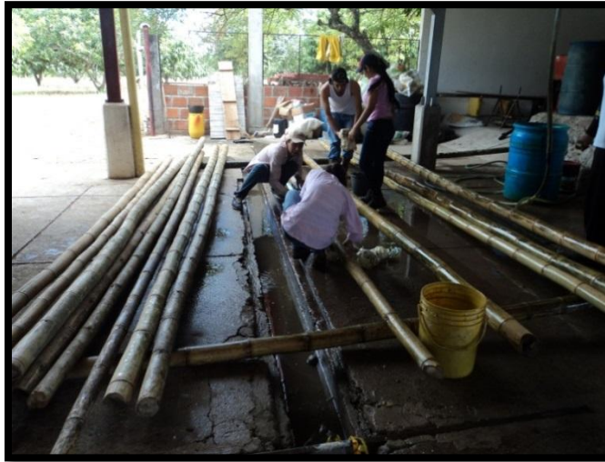
Ilustración 17. Lavado de la Guadua
