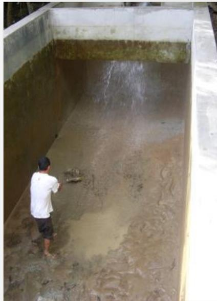
**Figura 22. Lavado del Desarenador**
