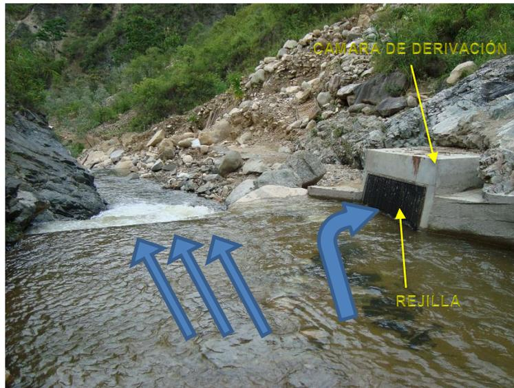
**Figura 17.** Bocatoma Lateral Distrito de Riego Llanos de la Virgen Mpio Altamira Dpto Huila
