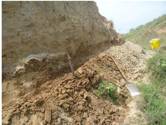
Figura 17. Zanja de siembra
