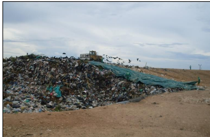
Foto 4. Maquinaria haciendo labor de compactación y cobertura
