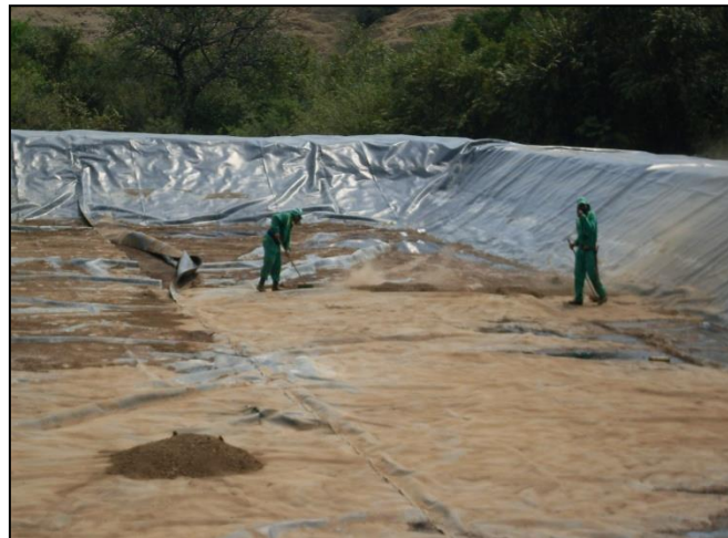
Foto 2. Filtros colectores de lixiviados
