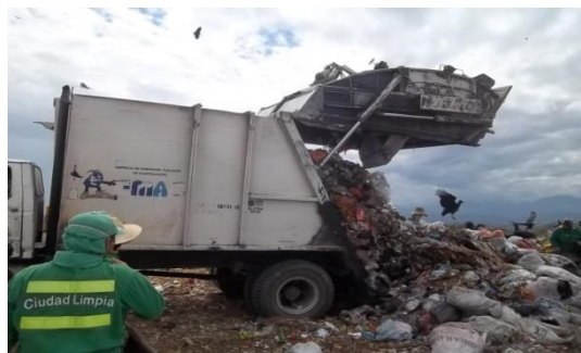
Foto 9. Disposición de los residuos sólidos en las celdas del relleno Sanitario
