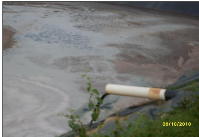
Foto 2. Filtros colectores de lixiviados
