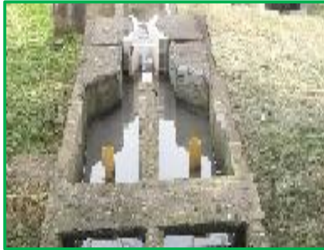
FIGURA 24. DESARENADOR
