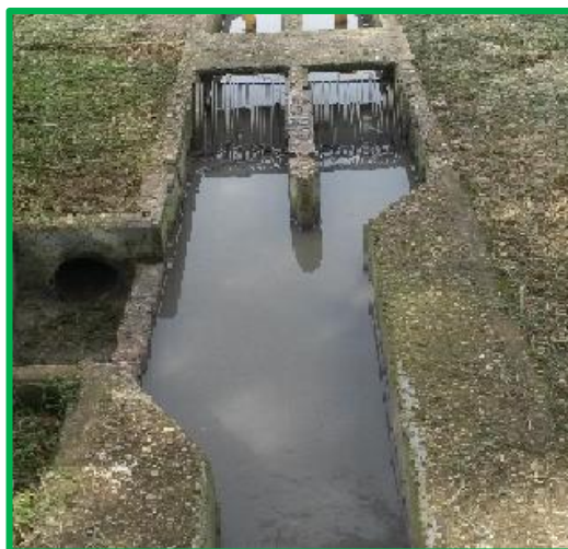
FIGURA 23. REJILLAS DE CRIBADO.
