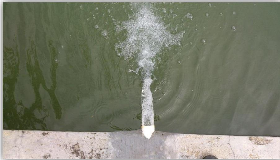
**Figura 28. Lavado de tubería de conducción pozo – tanque de almacenamiento.**
