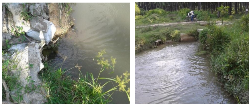
Figura 48. Captación canal PALO ALTO. Plantación el Castillo 2014
