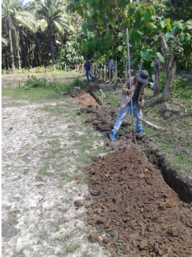
Imagen 19. Excavación de zanja para tubería principal y múltiple a pala
