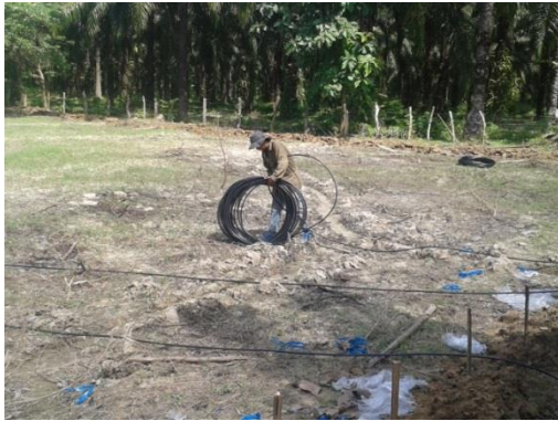
Imagen 21. Instalación de manguera lateral
