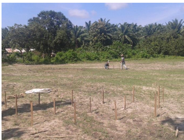
Imagen 14. Estacado y alineación de vivero
