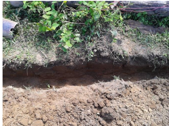
Imagen 19. Excavación de zanja para tubería principal y múltiple a pala
