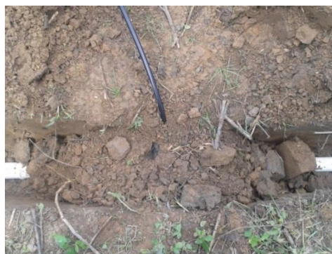
Imagen 20. Instalación de manguera lateral, conexión a tubería múltiple
