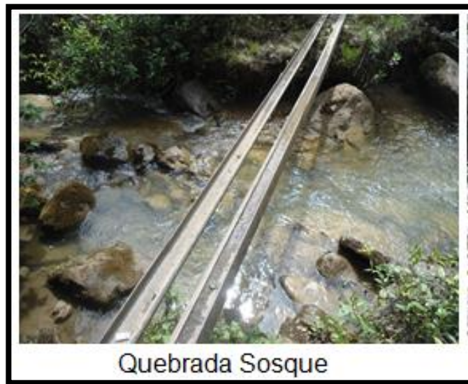
Figura 17. Sitio de Captación quebrada Sosque
