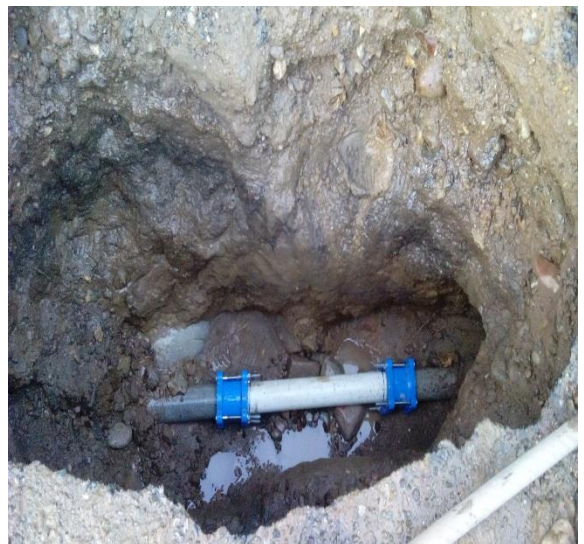
Imagen No 7: Reparación del daño
