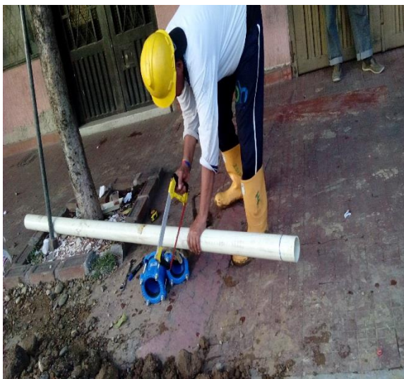
Imagen No 6: Corte de nueva tubería
