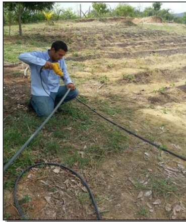
Figura 4. Instalación del sistema de riego para el cultivo de melón (goteo)
