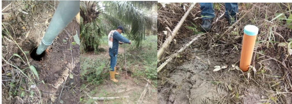
Figura 23. Instalación de los pozos de observación
