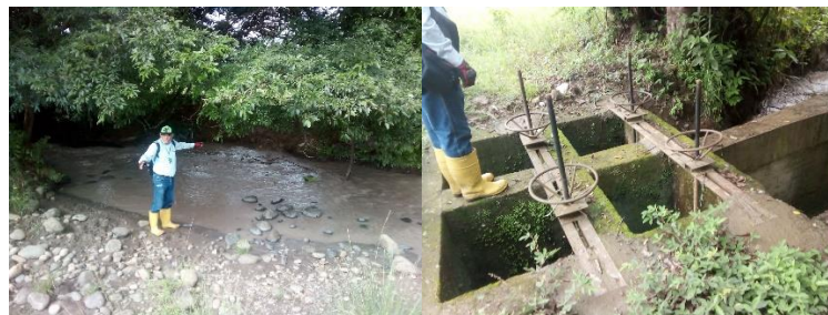
Figura 5. Acompañamiento del personal en la labor de identificación de obras
