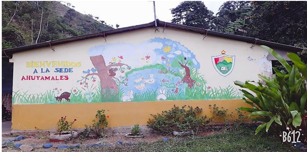
Figure 10 Sede Ahuyamales Fuente: Propia
