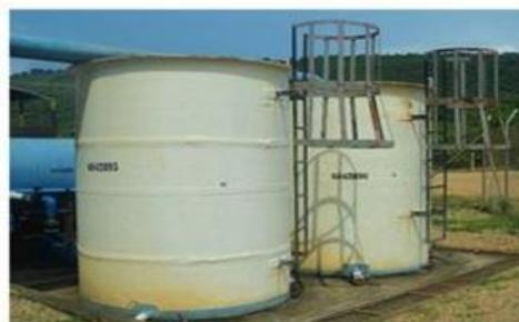
**Foto 44 Tanques de cabeza hidráulica**
