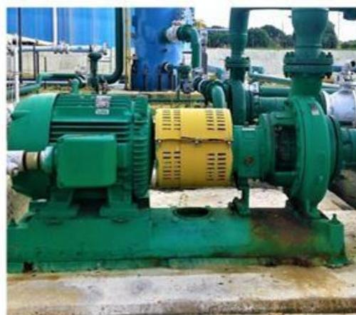
**Foto 53** Bomba de transferencia a filtro P201 C
