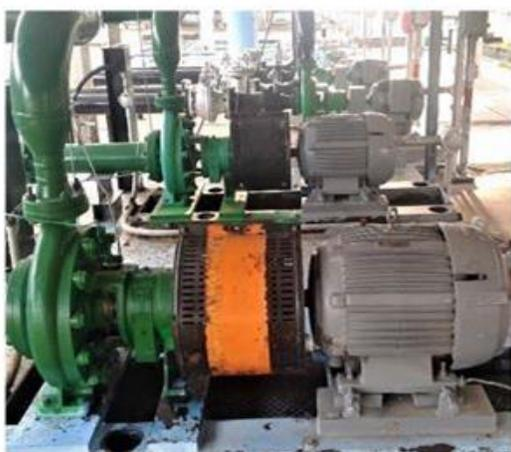
**Foto 52** Bombas de transferencia a filtros P201 A/B
