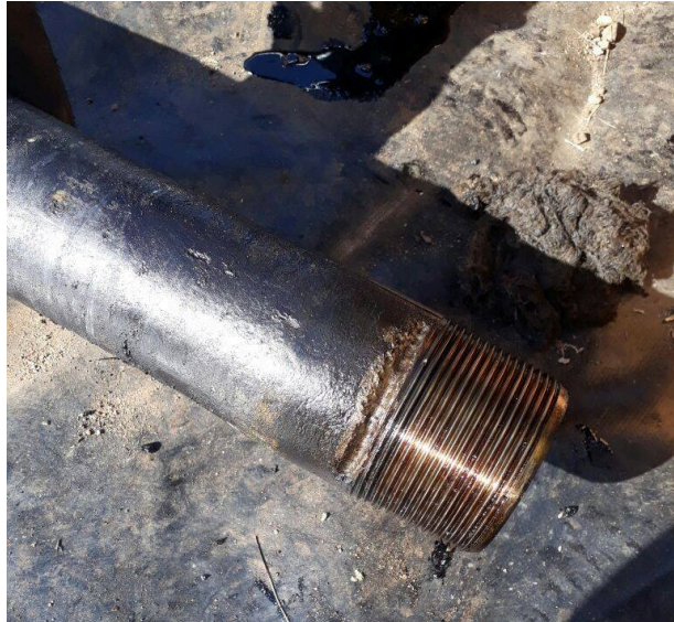
Figura 23. Corrosión externa en área de conexión
