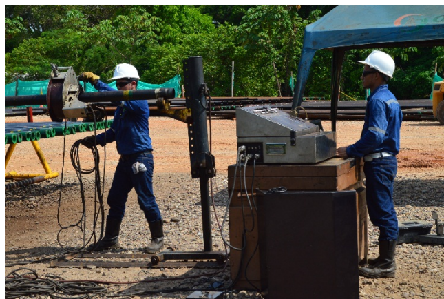
Figura 24. Inspección con EMI (ATP ingeniería)
