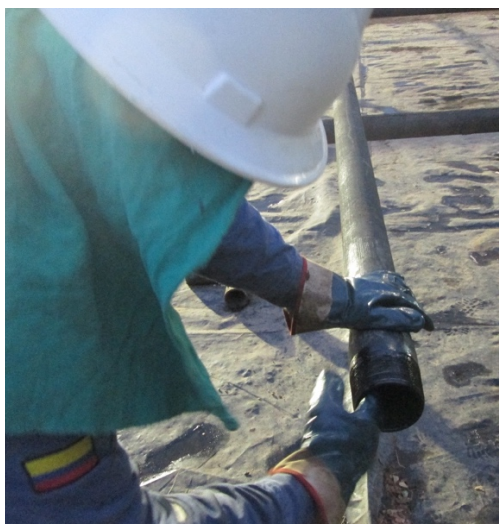
Figura 8. Método inspección visual de tubería
