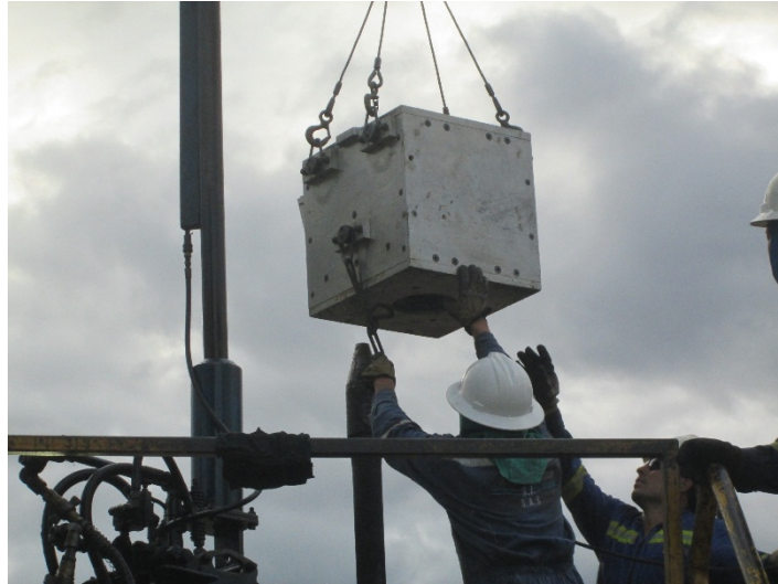
Figura 34. Introduciendo el equipo con ayuda de la bala de inserción
