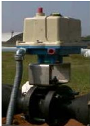
Ilustración 58. Válvulas de control de flujo.
