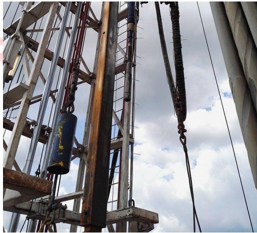
Figura 63. Ascenso a la torre
