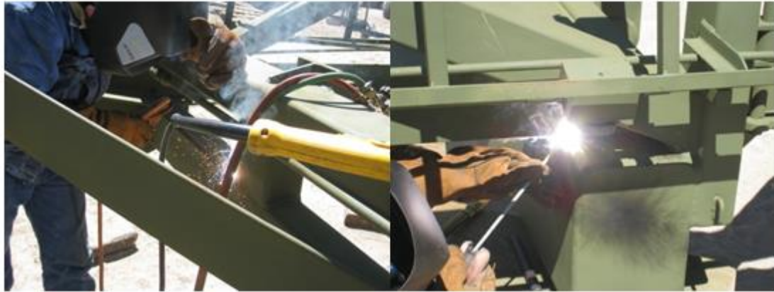
Figura 49. procedimientos de aplicación de la soldadura Welduct, Norma ASW/ ASME – SFA-5.5 Fuente: S.I (Servicios de Inspección)
