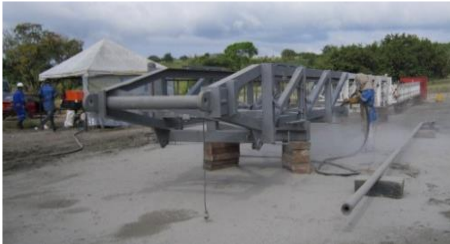
Figura 39. Capas de protección contra la lluvia Fuente: S.I (Servicios de Inspección)
