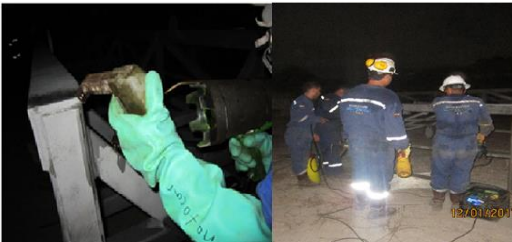
Figura 45. Re inspección por medio de partículas magnéticas de las zonas reparadas Fuente: S.I (Servicios de Inspección)
