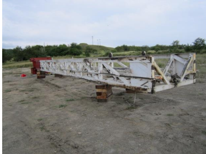
Figura 32. Segunda sección de la torre Fuente: S.I (Servicios de Inspección)
