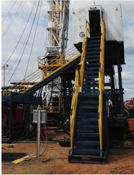
Figura 78. Acceso al piso de trabajo.
