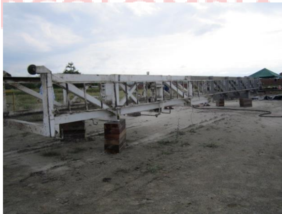
Figura 31. Primera sección de la torre Fuente: S.I (Servicios de Inspección)
