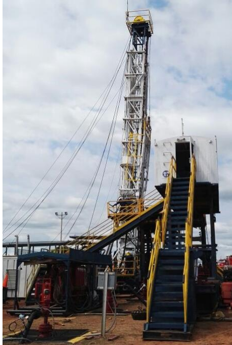
Figura 64. Sistema de ascenso a la torre.
