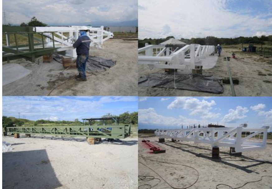
Figura 46. Trabajo de pintura en la torre con pintura especial, certificada a base de poliuretano. Fuente: S.I (Servicios de Inspección)
