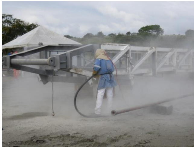
Figura 36. Tolva y manguera de presión Boquilla No. 5 Fuente: S.I (Servicios de Inspección)
