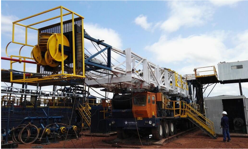
Figura 62. Izaje de la torre.
