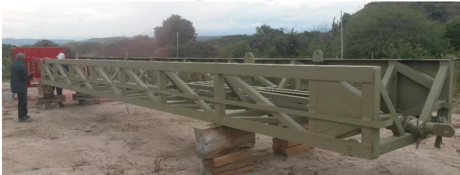
Figura 61. Inspección a las vigas y travesaños
