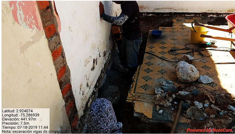
**Figura 15. Excavación de vigas de cimentación**
