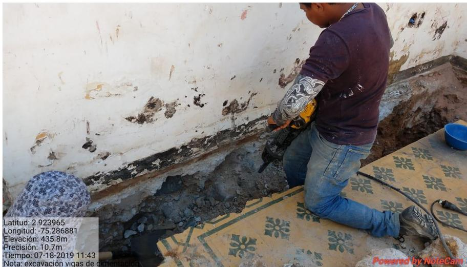
**Figura 16. Demolición de concreto ciclópeo existente en zapatas y vigas de cimentación**
