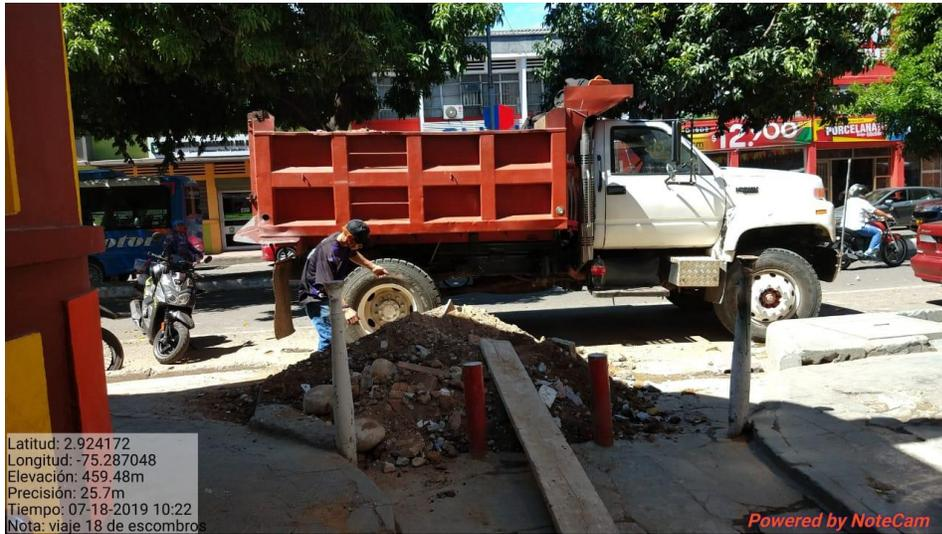
**Figura 17. Viaje de volqueta con escombros y material excavado**
