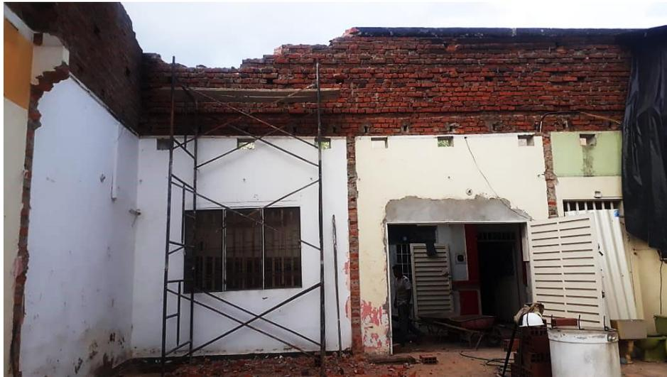
*Figura 7. Demolición parte superior de la fachada*
