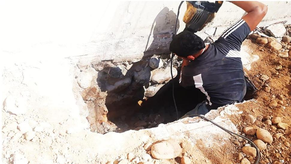
*Figura 8. Demolición concreto ciclópeo existente*
