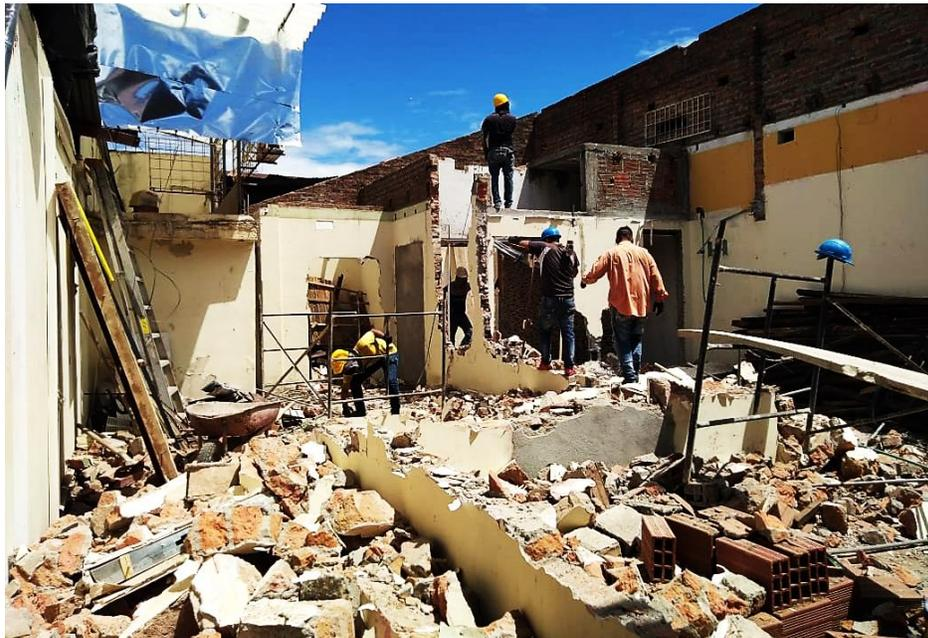
*Figura 5. Demolición de muros existentes*
