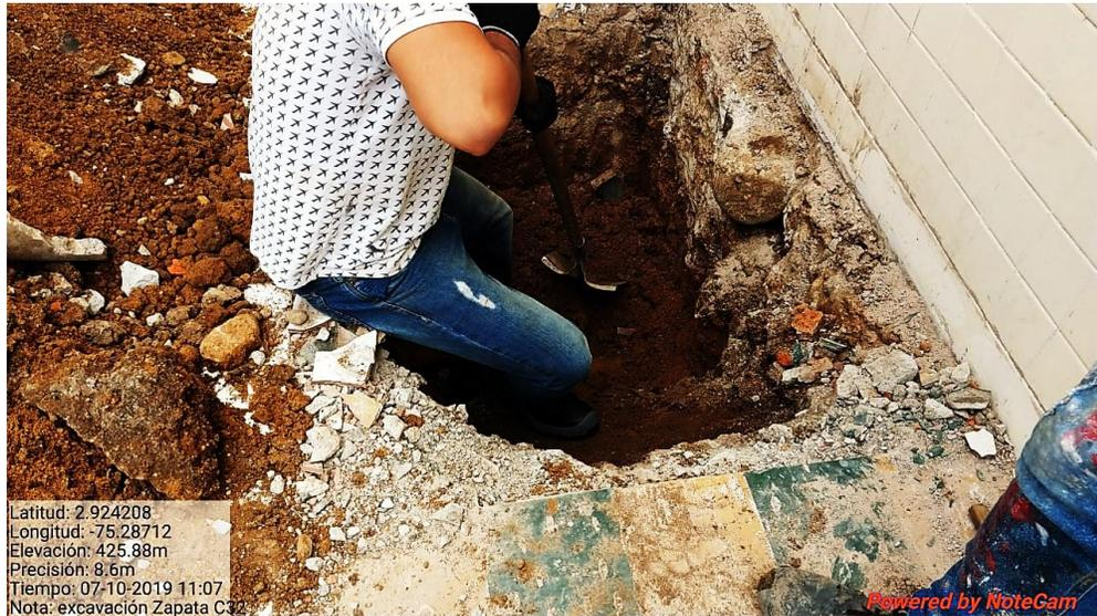
**Figura 9. Excavación de zapata C32**
