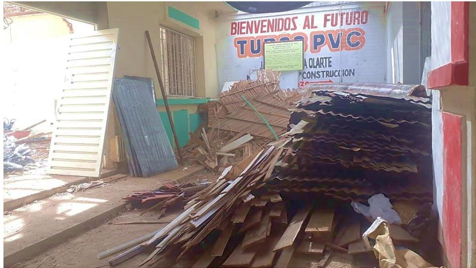
*Figura 4. Desmote de Cubierta*
