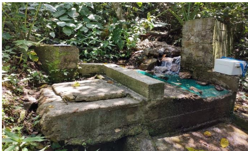
Fotografía 4-3 Bocatoma acueducto. Ancho del cauce: 1,6 metros
