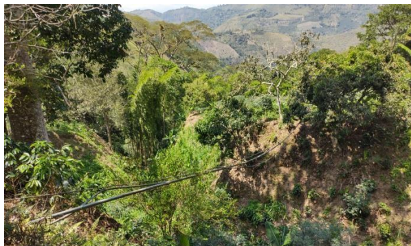
Fotografía 4-7 Tubería de aducción entre desarenador y tanques de almacenamiento.
