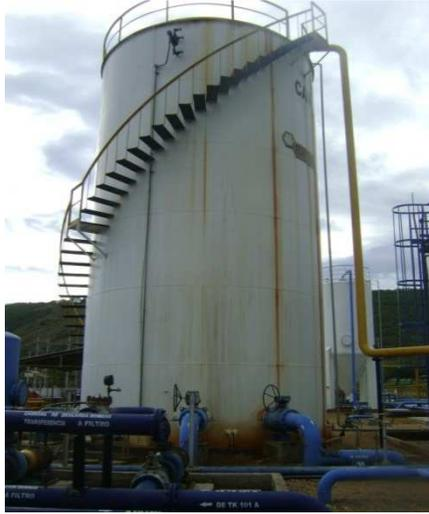
Fotografía 6 Tanque Cabeza de almacenamiento de agua. Fuente: Estación los mangos – campo Yaguará (Huila, Colombia).
