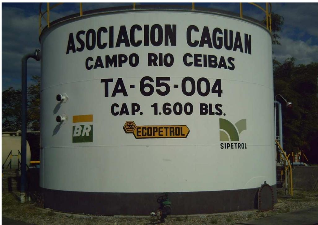
Fotografía 9. Imagen del tanque cabeza Tk – 003 de 1600 Bbbs de capacidad del Campo Río Ceibas. Tomado Manual de Procedimientos de Operación Campo Río Ceibas.
