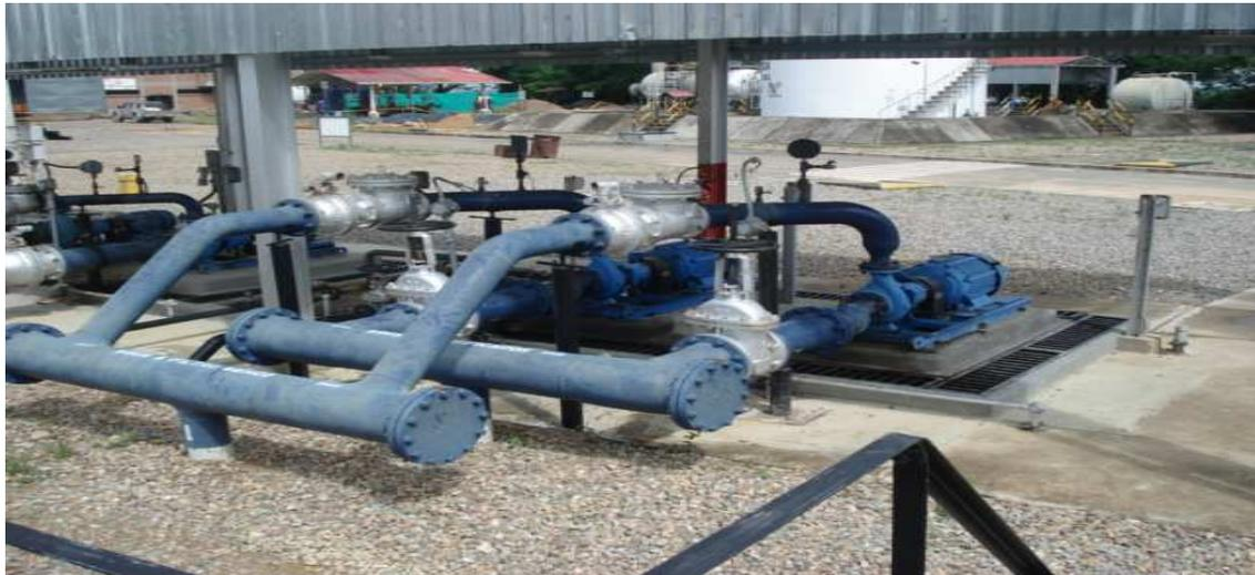
Fotografía 7. Bombas de transferencia Ingersoll – Rand P – 65 003 A/B. Tomado Manual de Procedimientos de Operación Campo Río Ceibas.
