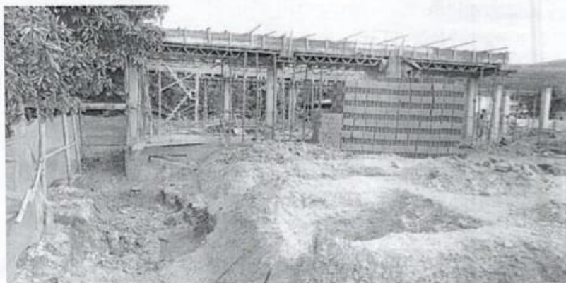
Fundición de concreto para muro de contención, parte posterior de Bloques 3 y 7
