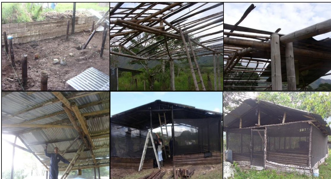
Figura 4. Construcción de la Estructura de la Biofabrica.
