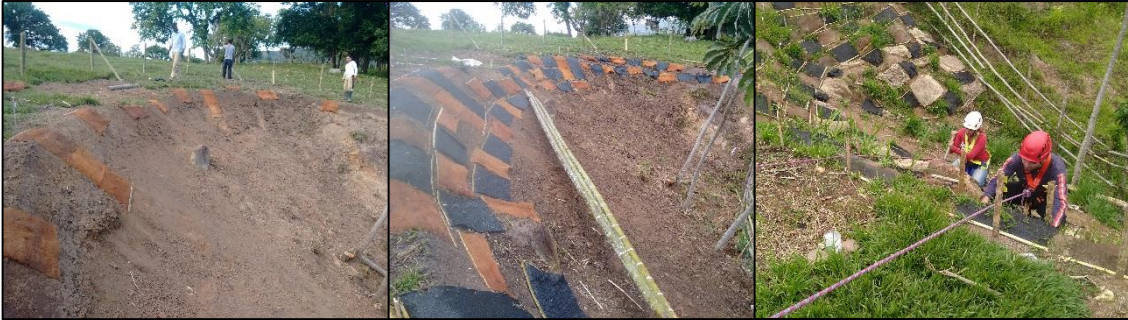
Figura 13. Montaje de las mallas de los diferentes tratamientos en la ladera objeto de estudio.
