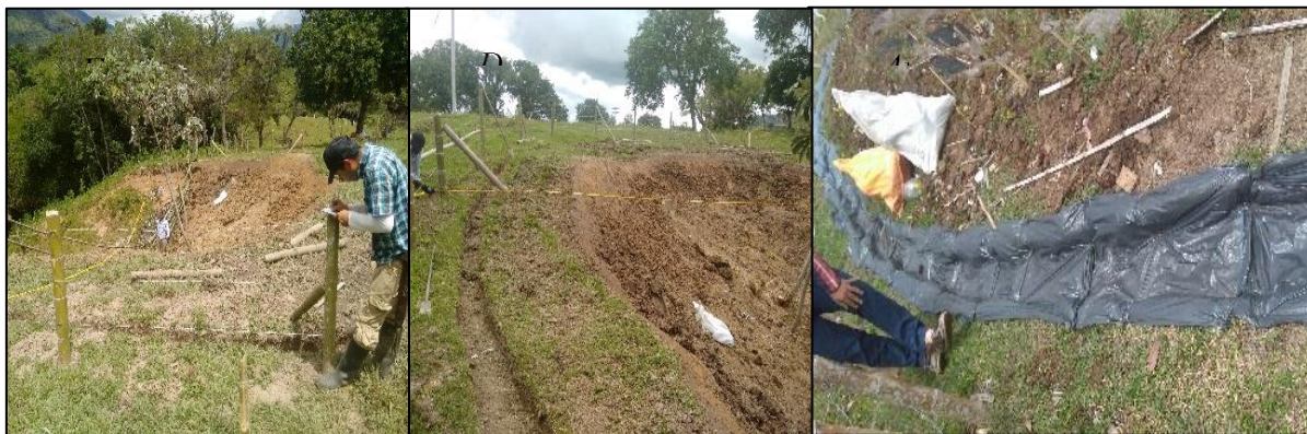
Figura 12. (A) Aislamiento de la zona de estudio. (B Y C) zanja de coronación.
